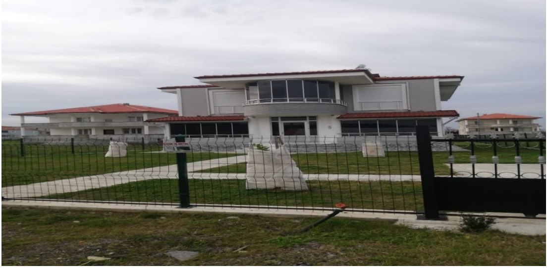
Şekil 5.28. 19 Mayıs İlçesine bağlı Dereköy Mahallesi'ndeki Konutlara Ait Görünüm
