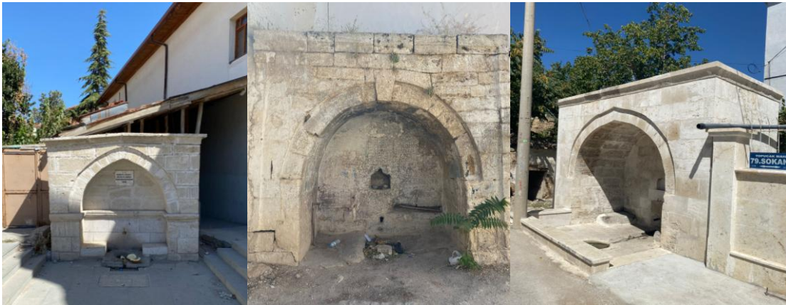
Şekil 4.37. Yenileme alanında bulunan çeşme yapılarından bazıları
