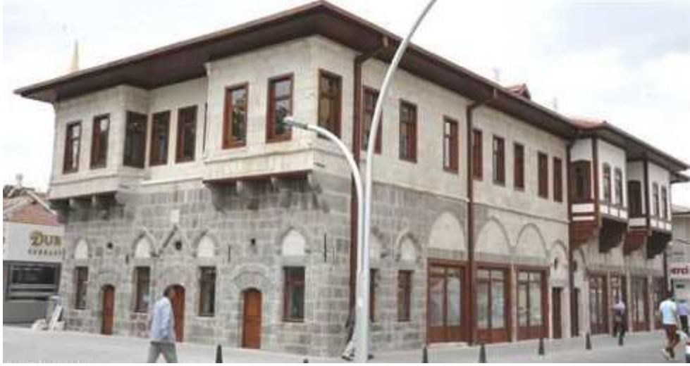
Şekil 4.13. Karaman Tarihi Belediye Binası [ URL-13]
