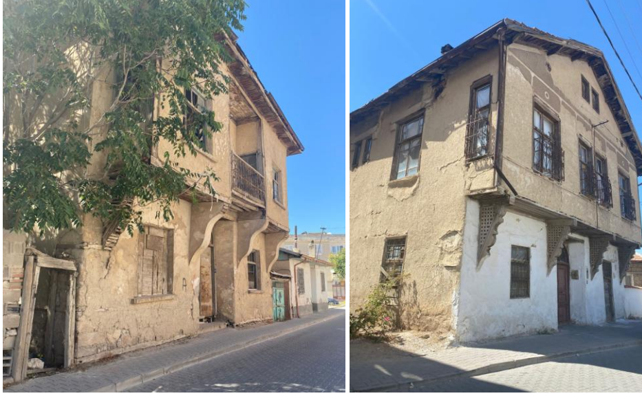
Şekil 4.38. Yenileme alanında yer alan konut yapılarından bazıları
