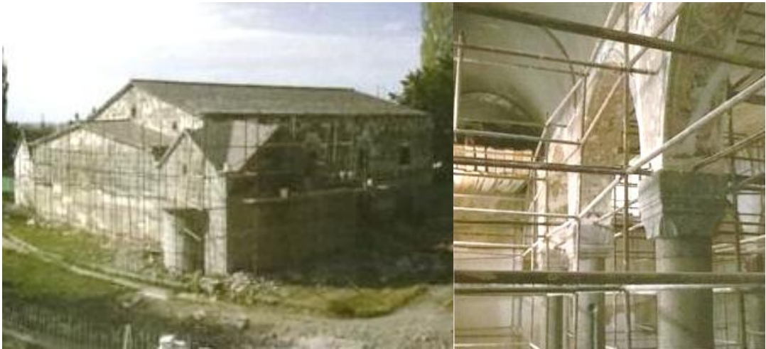
Şekil 4.44. Çeşmeli Kilise Restorasyon Çalışmalarından Görünümler (Karpuz,2009)
