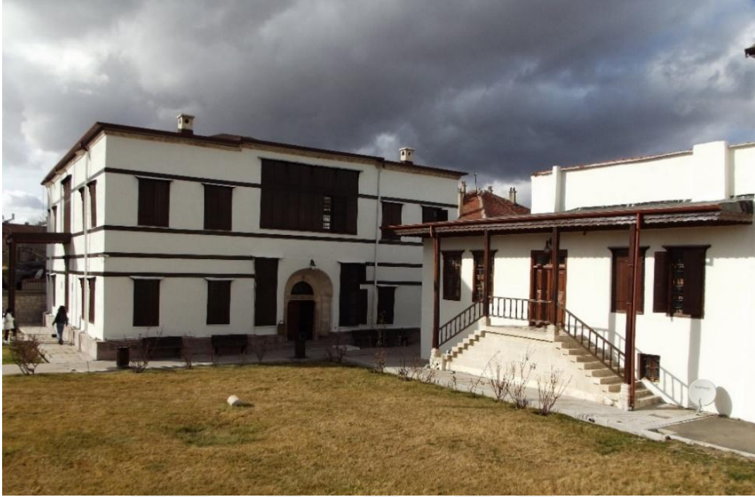
Şekil 4.48. Tartan Konağı Kent Müzesi Mevcut Görünüm
