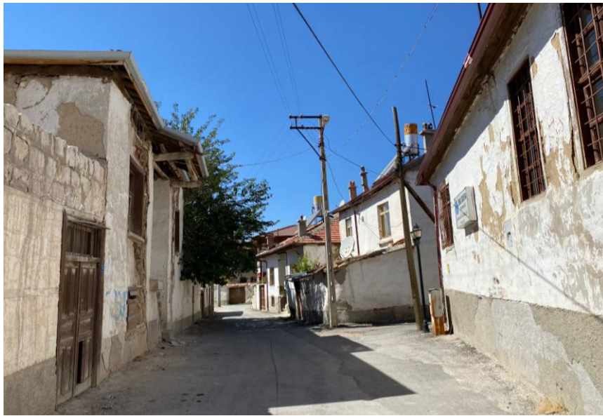
Şekil 4.40. Topucak bölgesi yenileme alanına ve yakın çevresine ait geleneksel sokak dokusu
