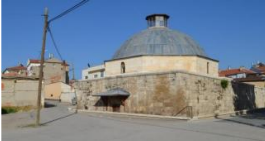
Şekil 4.47. Yeni Hamam Eski Görünüm (Karaman Belediyesi arşivi, 2018)
