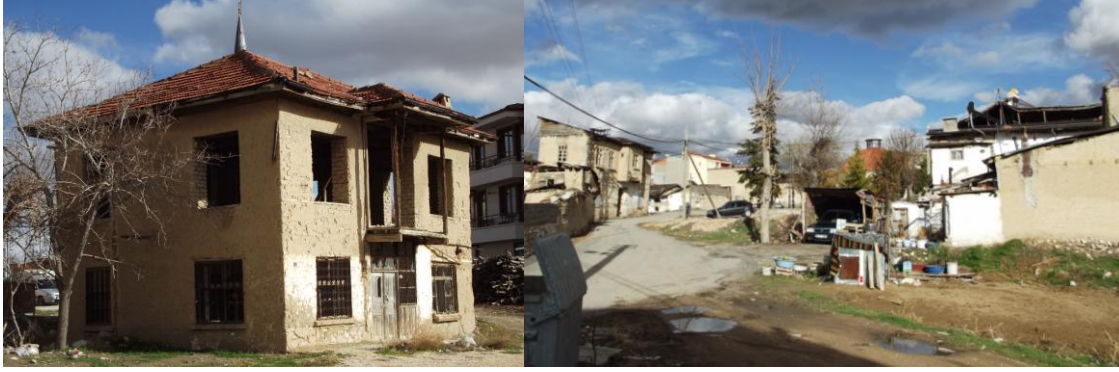
Şekil 4.72. Bölgedeki hasarlı yapılardan bir kısmı
