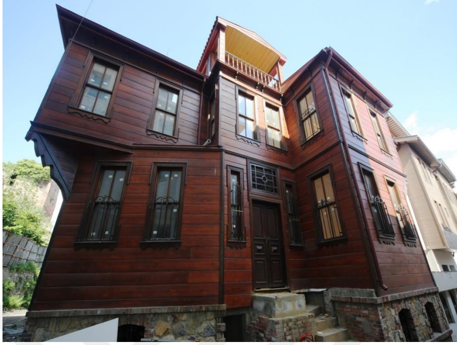
Şekil.12. 2868 Ada 7 Parsel Yenileme Sonrası Görünümü
