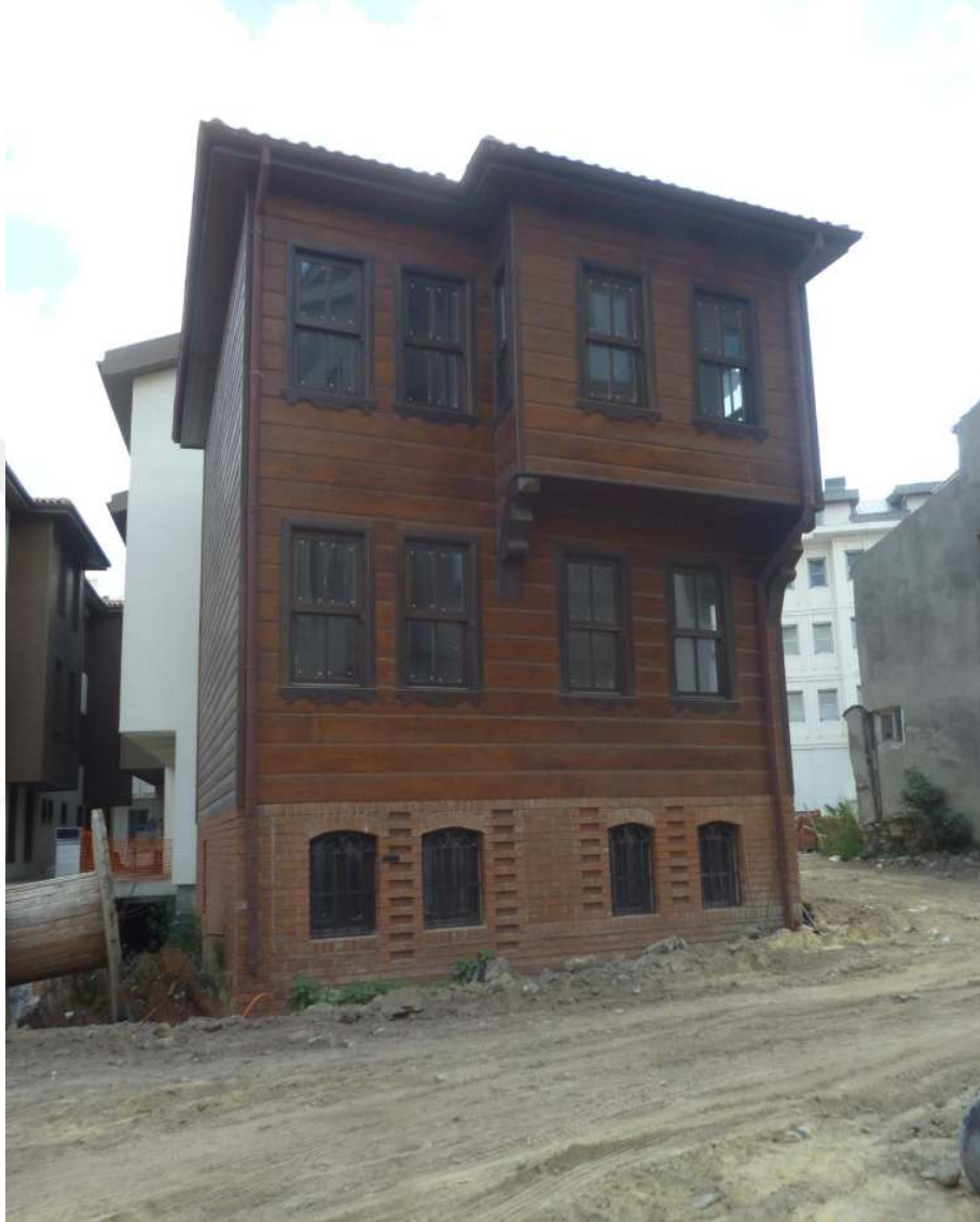
Şekil.18. 2869 Ada 2 Parsel Yenileme Sonrası (Yeni Yapı)
