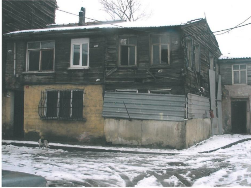
Şekil.7. 2867 Ada, 66 ve 67 Parsellerde Yer Alan Yapıların Envanter Kaydı ve Görünümleri
