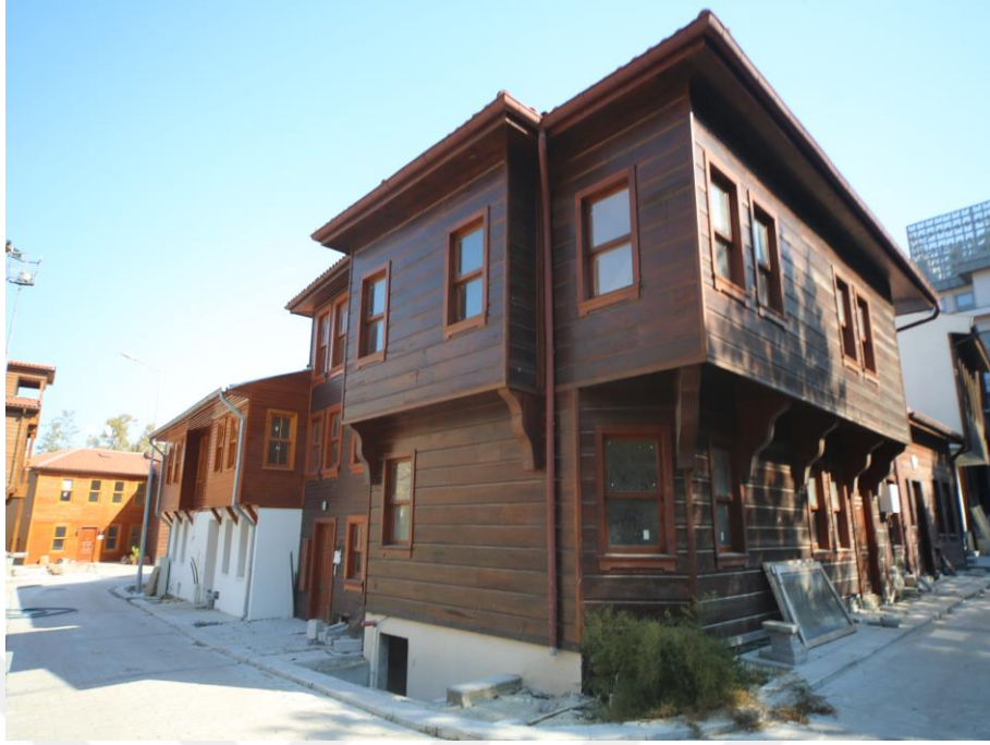
Şekil.10. 2868 Ada 1 Parsel Yenileme Sonrası Görünümü
