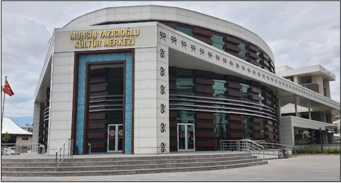
Şekil 4. 14: Muhsin Yazıcıoğlu Kültür Merkezi'ne Ait Bir Görünüm
