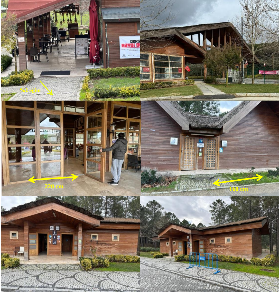
Şekil 4.3: Bina girişlerine ait rampalar.
