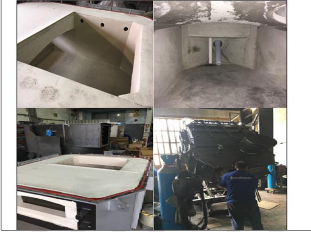
Şekil 4.32 Filtreleme havuzu mekanik montajından görseller
