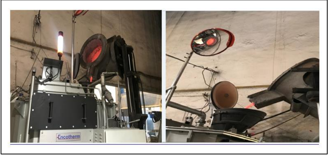
Şekil 4.36 Filtreleme havuzuna ilk yükleme görüntüsü
