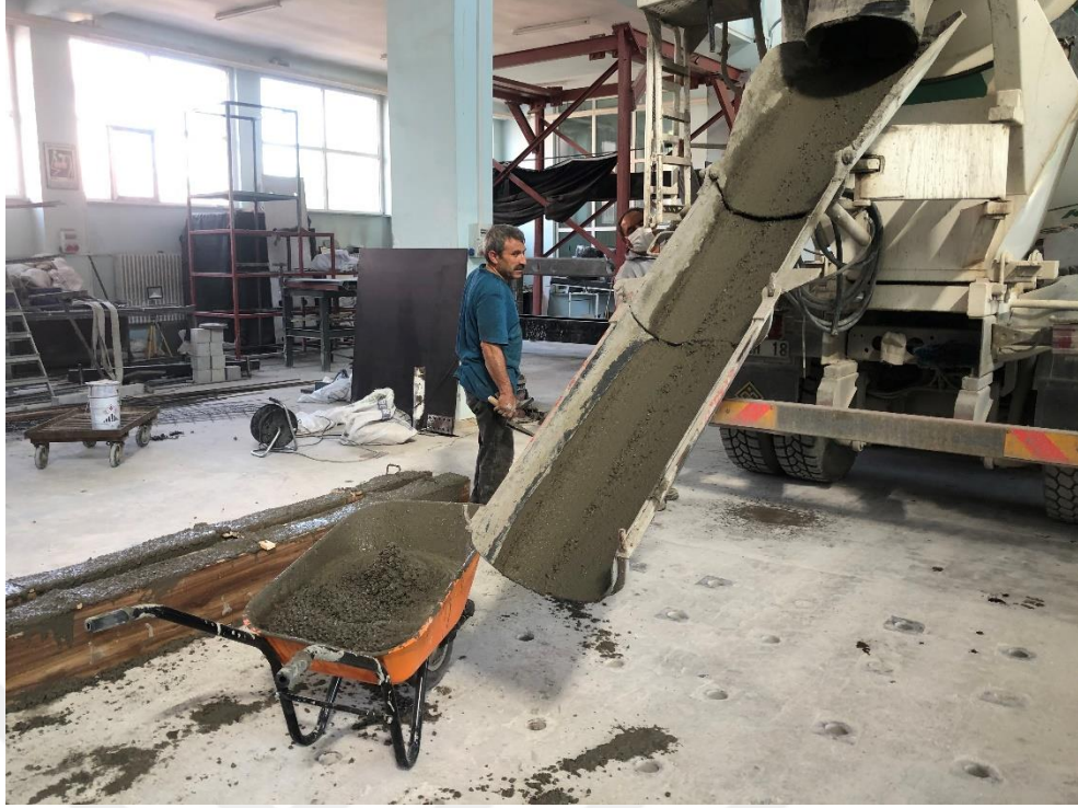
Şekil 3.5. Beton dökme aşaması
