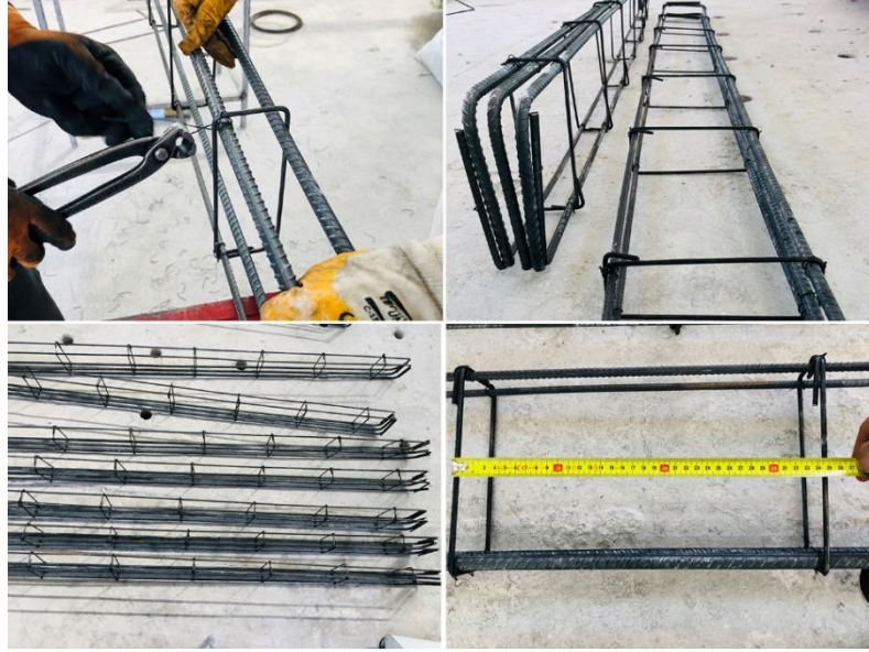
Şekil 3.12. Donatı kafesini hazırlama aşaması
