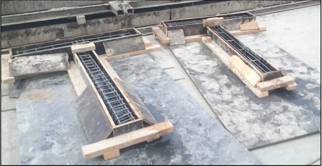
Şekil 3.9. Donatıların kalıp içine yerleşimi
