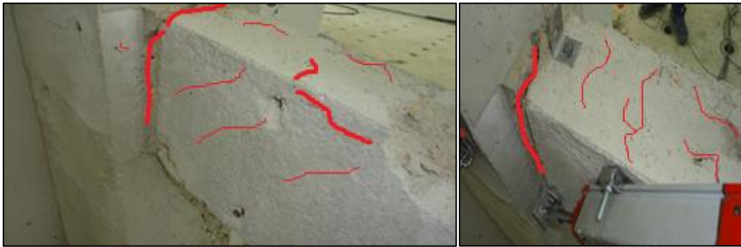
Şekil 4.36. S4 deney elemanında meydana gelen çatlak gelişimi
