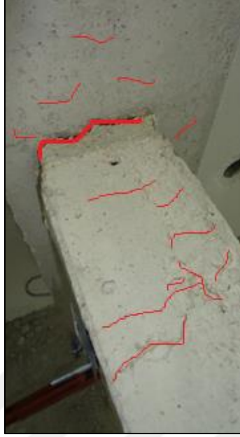
Şekil 4.54. S6 deney elemanında meydana gelen çatlak gelişimi.
