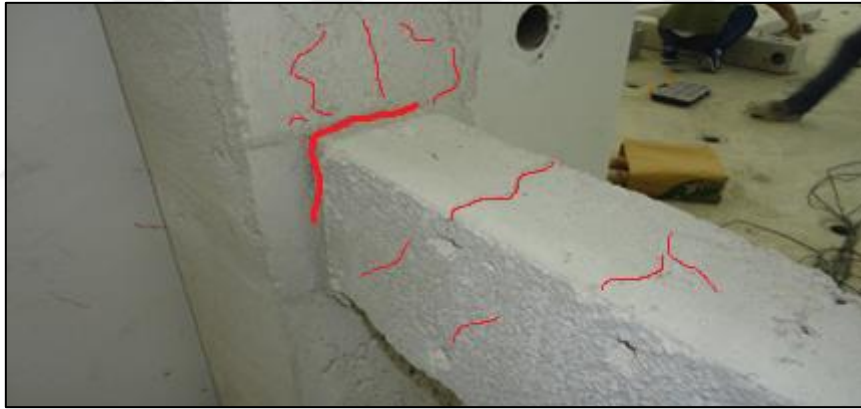
Şekil 4.18. S2 deney elemanında meydana gelen çatlak gelişimi
