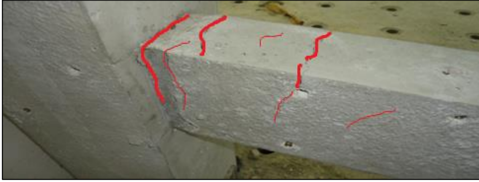
Şekil 4.126. S14 deney elemanında meydana gelen çatlak gelişimi
