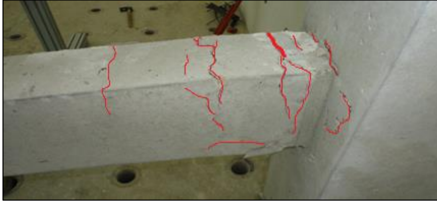
Şekil 4.99. S11 deney elemanında meydana gelen çatlak gelişimi
