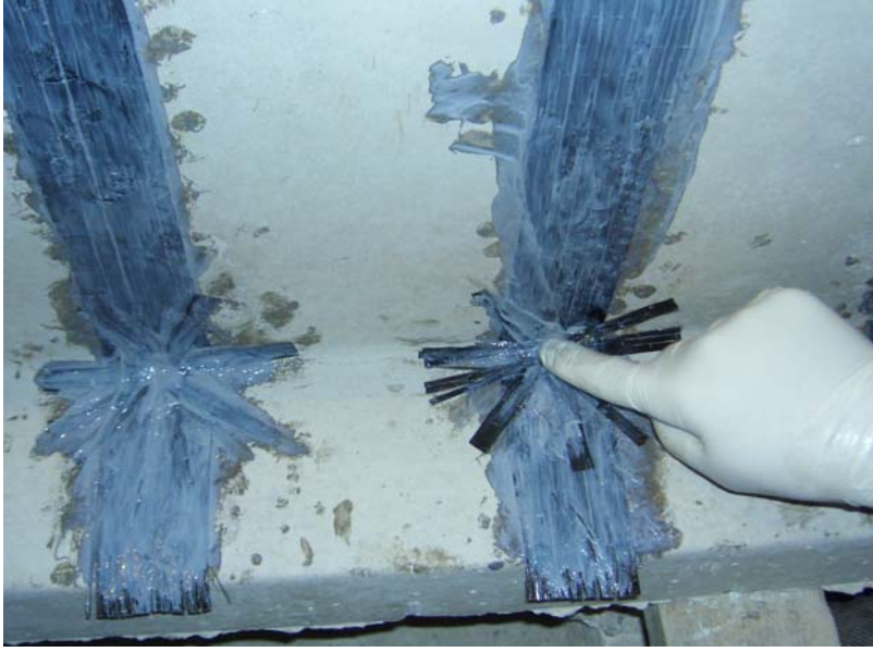
Resim 2.2. Kirişte fan ankraj uygulanması
