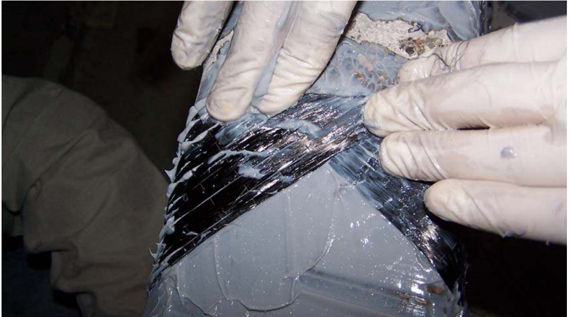
Resim 2.4. CFRP şeridin kiriş altında doğrultu değiştirmesi
