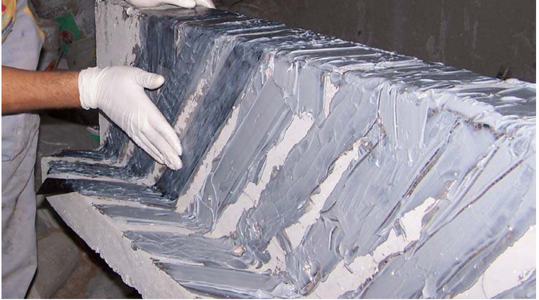
Resim 2.3. CFRP şeritlerin kirişe yapıştırılması
