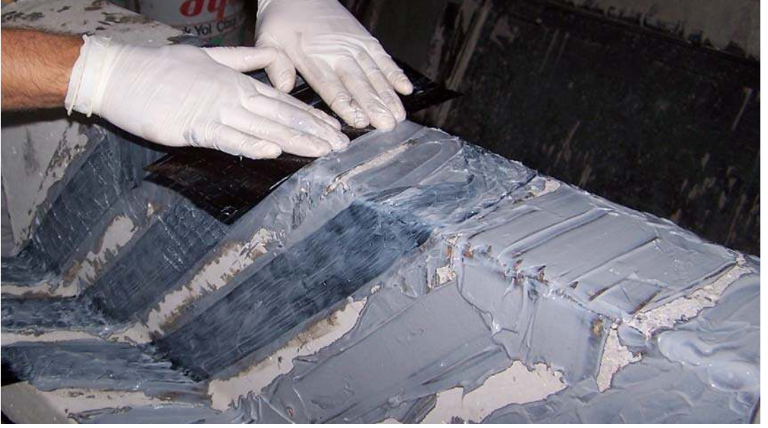
Resim 2.5. 100 x 250 mm'lik CFRP parçaların kiriş altına yapıştırılması
