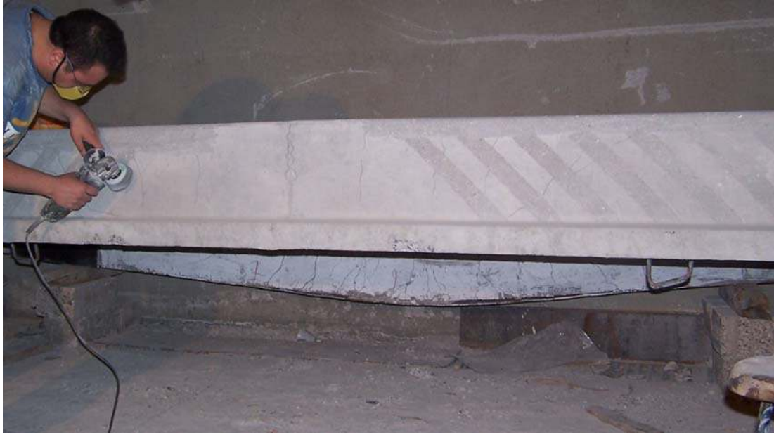
Resim 2.2. Kiriş yüzeyinin hazırlanması
