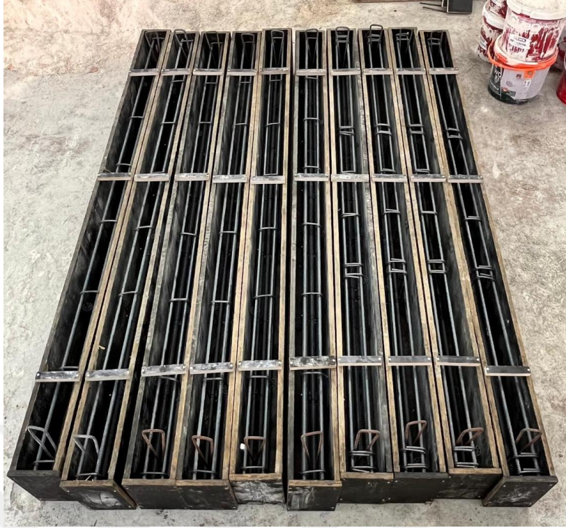
Şekil 3.7. Donatıların kalıplara yerleştirilme aşaması
