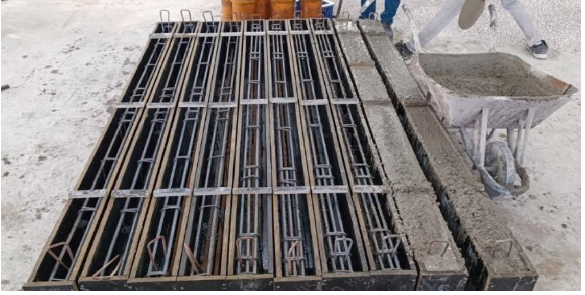
Şekil 3.8. Kalıplara beton dökülme aşaması
