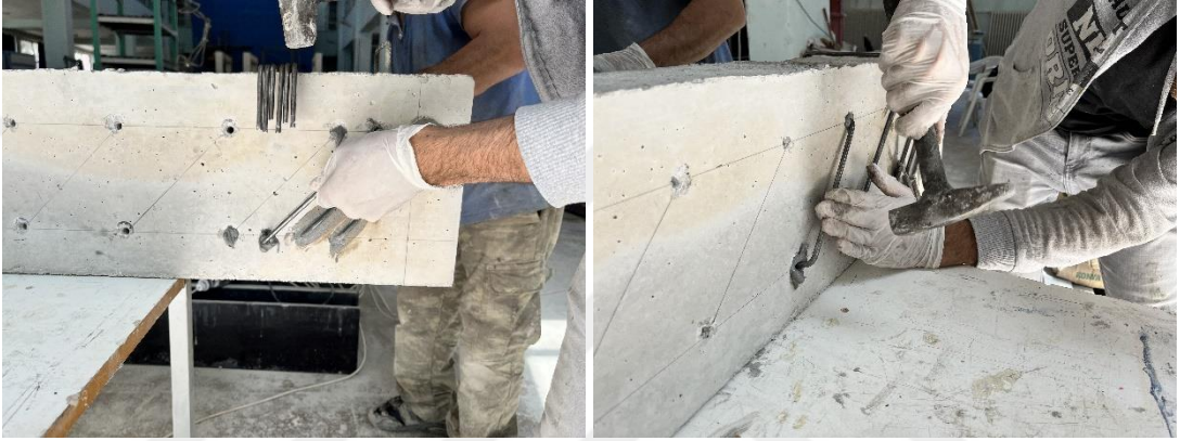
Şekil 3.17. Mekanik dikişlerin deliklere yerleştirilmesi
