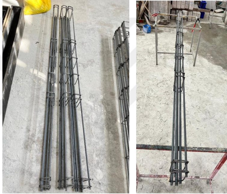
Şekil 3.6. Donatı hazırlama aşaması
