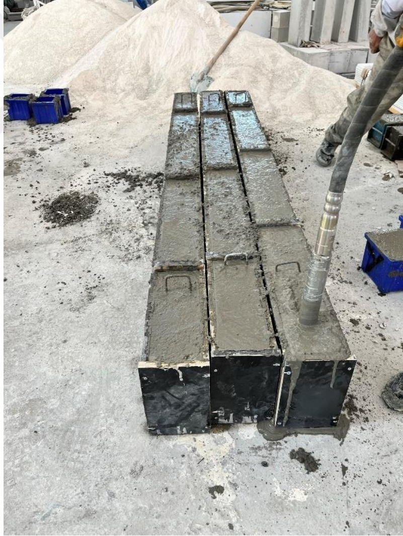
Şekil 3.9. Betonun dökümü sırasında vibratör uygulaması
