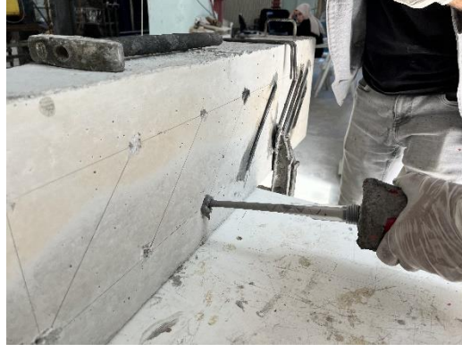
Şekil 3.16. Temizlenen ankraj deliklerinin epoksi ile doldurulması
