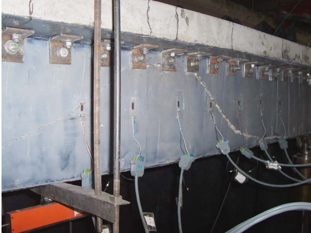
Şekil 3.39 Deney elemanı 7'nin deformasyon ölçerleri ve kesme çatlağı
