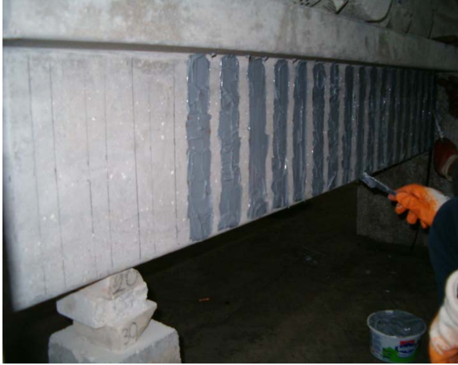
Şekil 2.4 Sikadur 330 uygulaması
