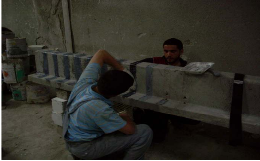
Resim 2.5. CFRP şeritlerinin kiriş yüzeyine yapıştırılması
