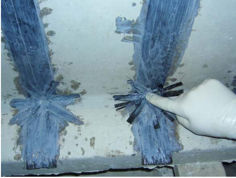
Resim 2.7. Kirişte ankraj uygulaması
