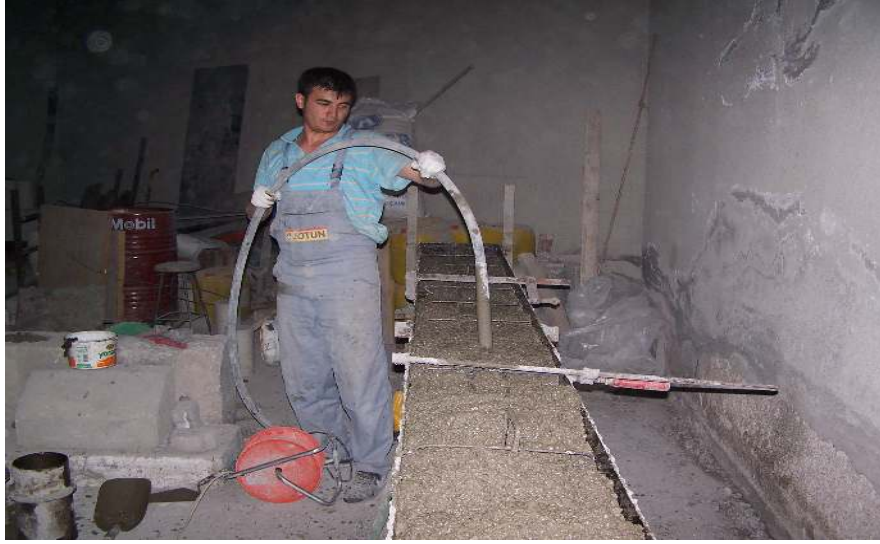
Resim 2.1. Beton dökümü
