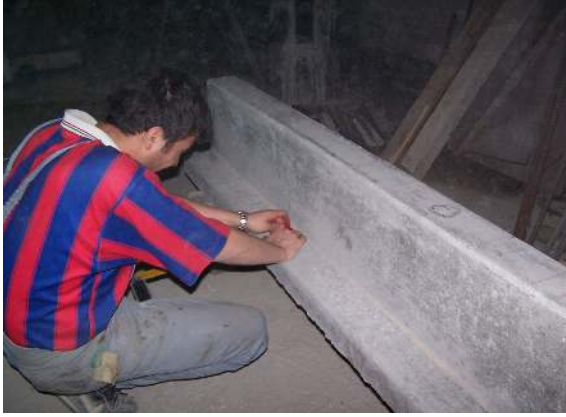
Resim 2.3. CFRP şerit yerleşiminin işaretlenmesi
