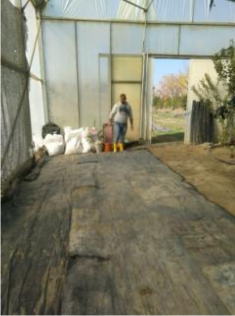
Şekil 3. 4. Sera tabanına malç naylonunun serilmesi
