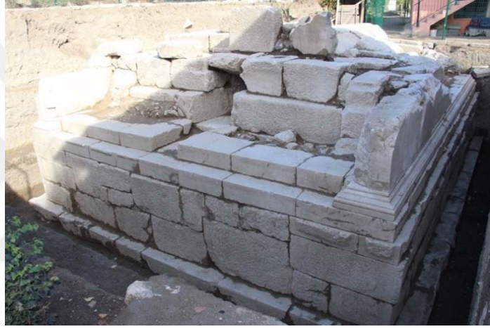
Resim 75: Güney Cephe Podyum Alt Örgü Sistemi.
