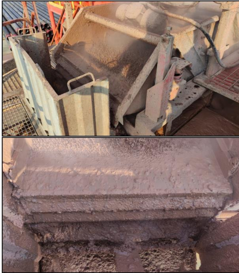
Şekil 3.3. Shale shaker (elek) kesintileri çamurda ayrıştırırken
