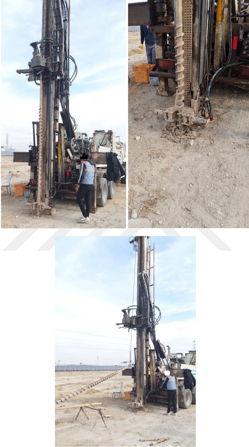
Şekil 4.7. KOS Atık Su Arıtma Tesisi sondaj çalışması
