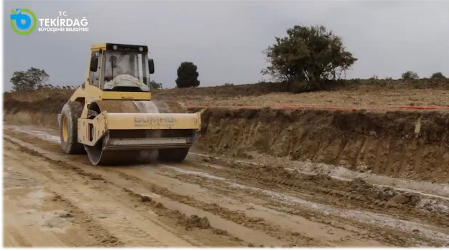
Şekil 2.14: Zeminin titreşimli silindir ile düzeltilmesi (Tekirdağ B.B. 2018)
