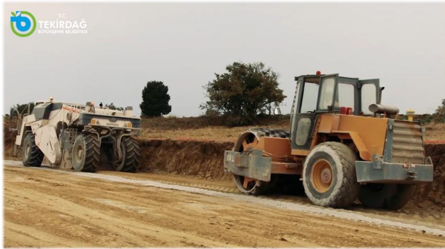
Şekil 2.11: Keçi ayaklı silindir ile zemin sıkıştırılması (Tekirdağ B.B. 2018)
