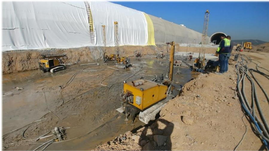
Şekil 2.5: Zemin – çimento enjeksiyonu. (2017 Sabiha Gökçen havalimanı 2.pist inşaatı)
