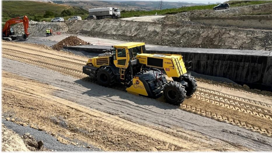
Şekil 2.10: Zemin ile kirecin karıştırılması (İstanbul 2025)
