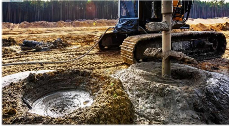
Şekil 2.7: Derin zemin karıştırma ( www.totemzemin.com )
