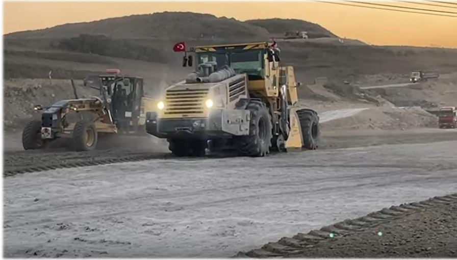
Şekil 2.13: Zeminin karıştırılması ve düzeltilmesi (İstanbul 2025)
