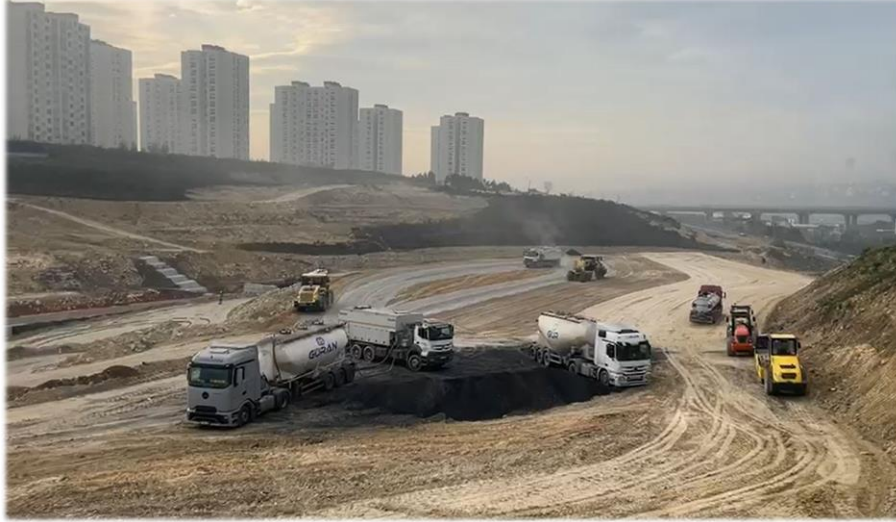
Şekil 2.15: Zemin iyileştirme sahası genel görünüm (İstanbul 2025)
