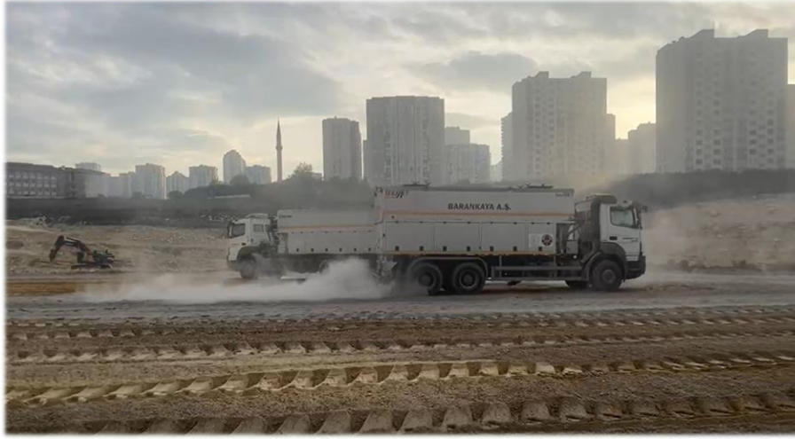
Şekil 2.9: Zemine kireç eklenmesi (İstanbul 2025)
