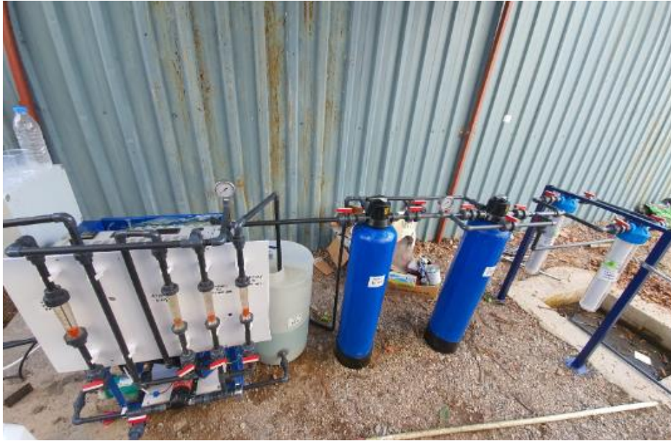
Şekil 3.10. Arıtma sisteminin devreye alınması
