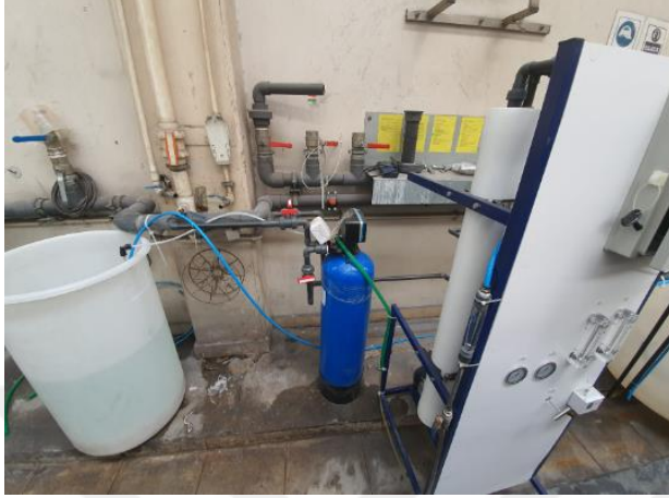
Şekil 4.2. Valfli yumuşatma filtresi ve RO sistemi
