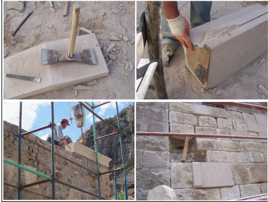
Resim 2.4 D ğ r t f leri kullanılarak yapılan Mevlevi (T rbe) Camii (Yapım tarihi: 1294  ncesi).
