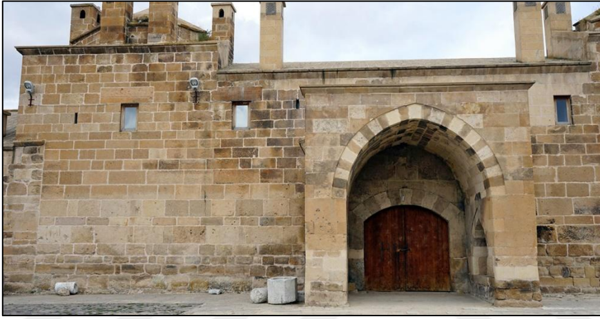
Resim 2.1 Döğer tüfleri kullanılarak yapılan Döğer Kervansarayı (Yapım tarihi: 1434).
