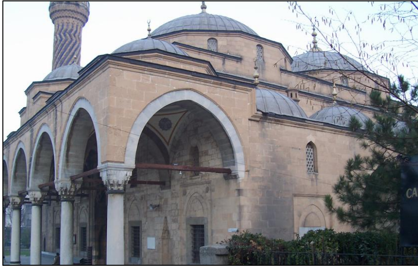
Resim 2.2 Döğer tüfleri kullanılarak yapılan İmarek Camii (Yapım tarihi: 1472).
