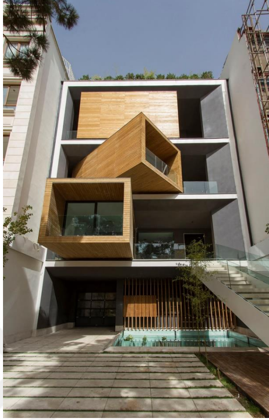
Şekil 23. Sharifi-ha Evi ön cephesi (URL-24, 2023)
