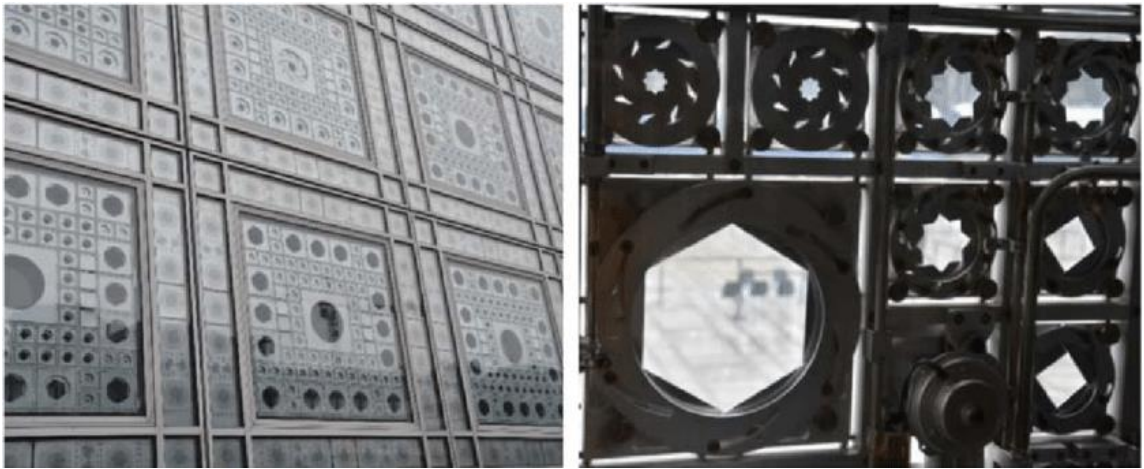
Şekil 33. Arap Dünya Enstitüsü cephesi (URL-34, 2023)
