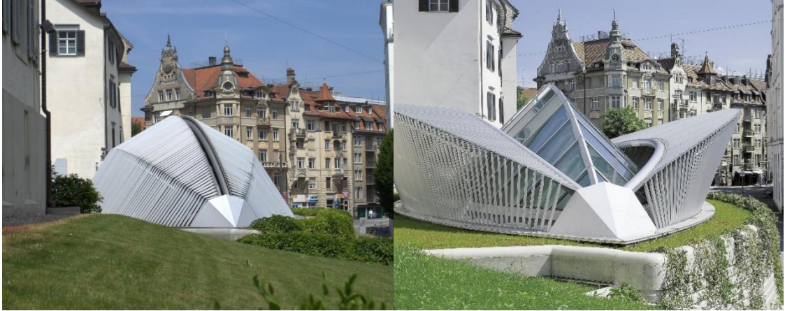
Şekil 29. Pfalz Keller Acil Servis Merkezi (URL-30, 2022)
