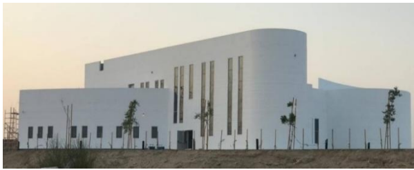
a) 3D teknolojisiyle inşa edilmiş bir yapı
