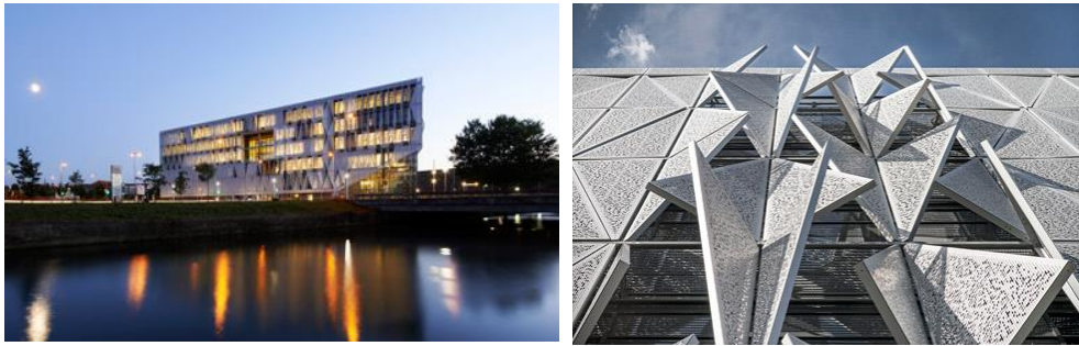
Şekil 5.23. SDU Campus Kolding Binası (URL-59)
