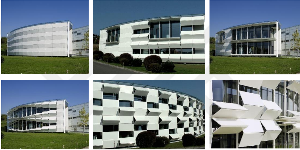
Şekil 5.46. Kiefer Technic Showroom'un kinetik cephesi (URL-89)
