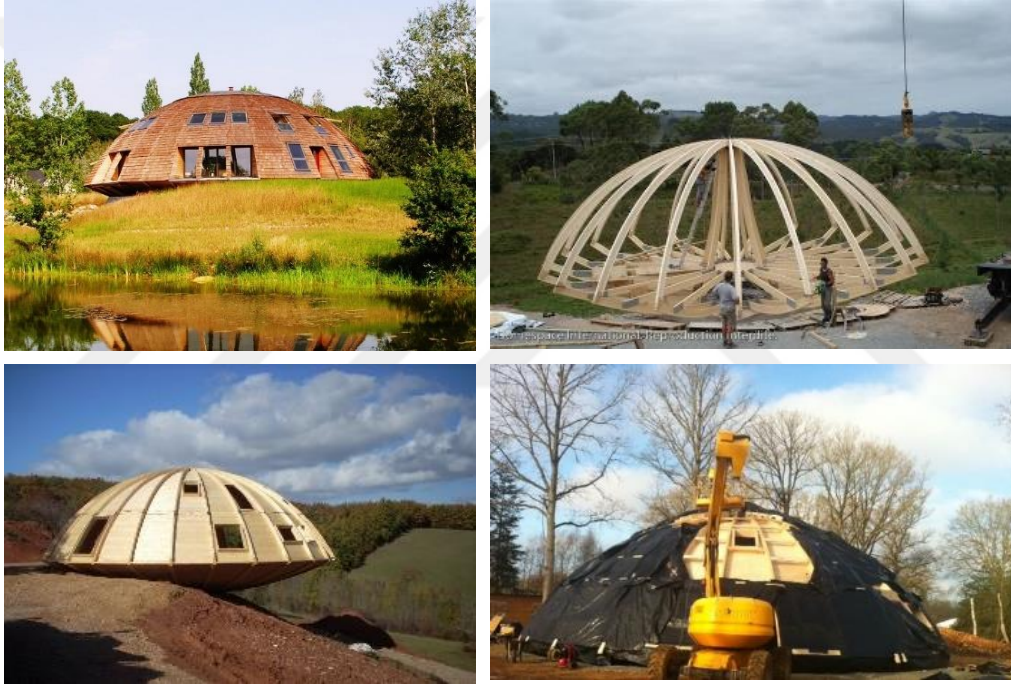
Şekil 5.33. Domespace yapım aşaması (URL-73)
