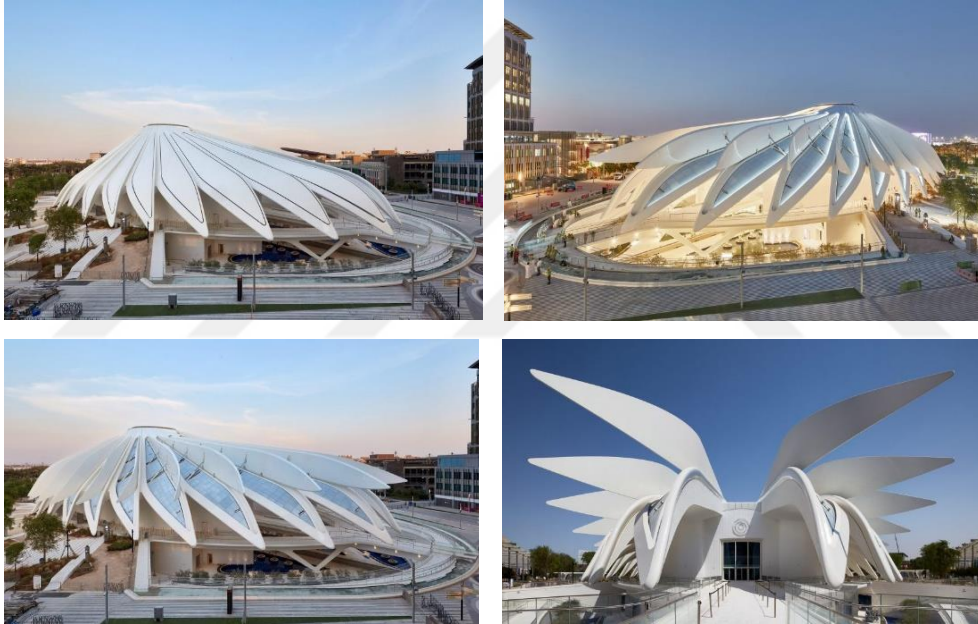
Şekil 5.24. UAE Pavilyon'un hareketli çatı kanatları (URL-60)
