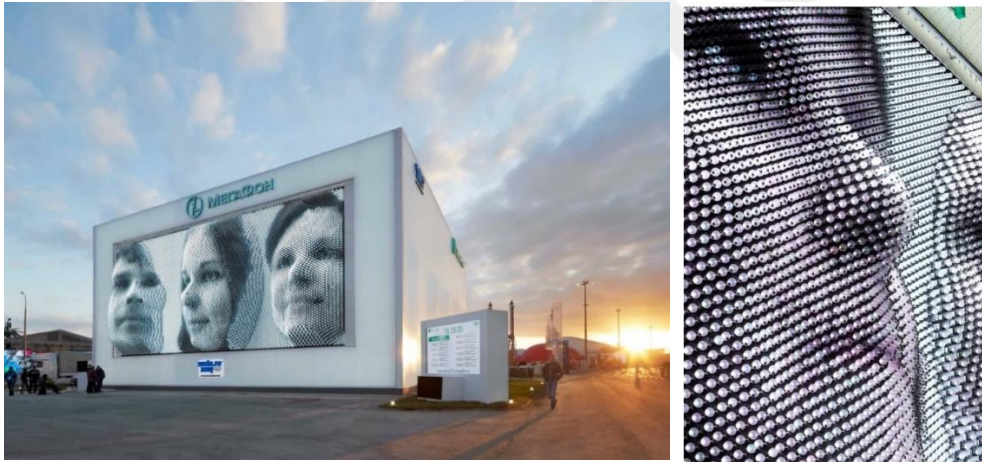
Şekil 5.22. MegaFaces, üç boyutlu elektronik-kinetik cephe (URL-58)
