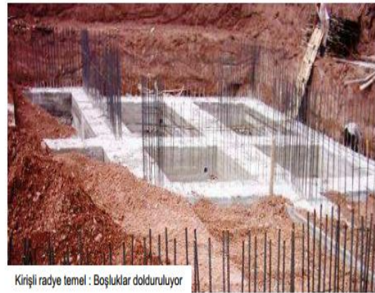
Şekil 3.18. Kirişli radye temel imalatı, kalıbı, beton dökümü ve blokaj işlemi (URL-6).
