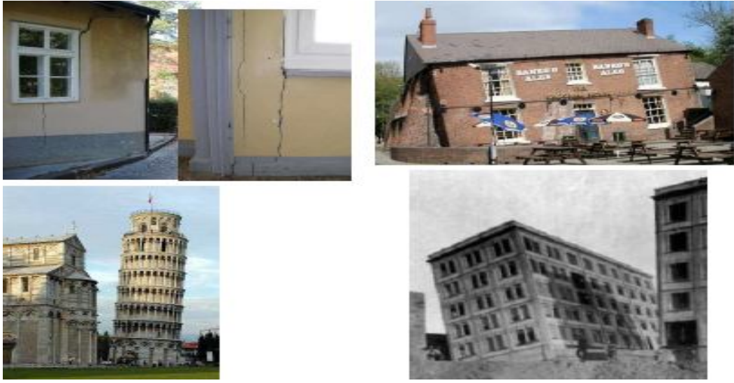
Şekil 2.2. Yapılarda meydana gelen farklı oturmalar sonucu hasarlı ve yan yatan yapılar (URL – 2).
