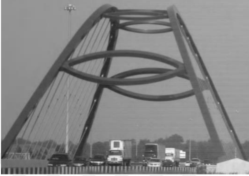
Şekil 2.11. Çelik kemer köprü (Fu, 2013)
