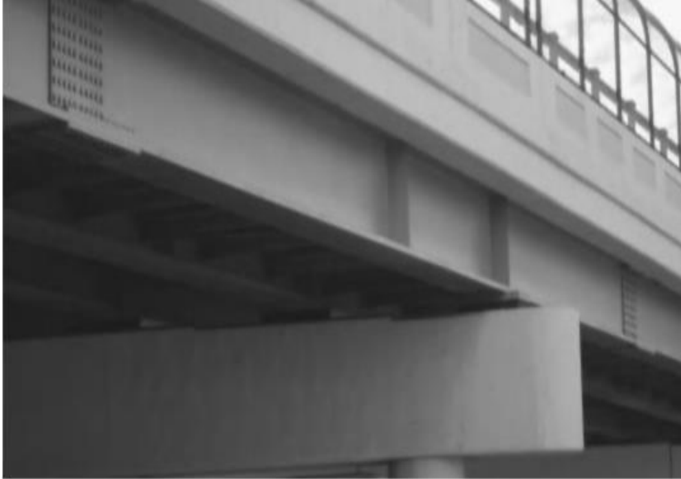
Şekil 2.6. Sürekli kirişli çelik köprü (Fu, 2013)
