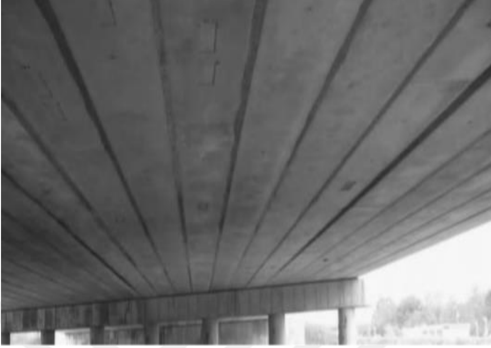
Şekil 2.9. Öngerilmeli beton kutu kiriş köprü (Fu, 2013)
