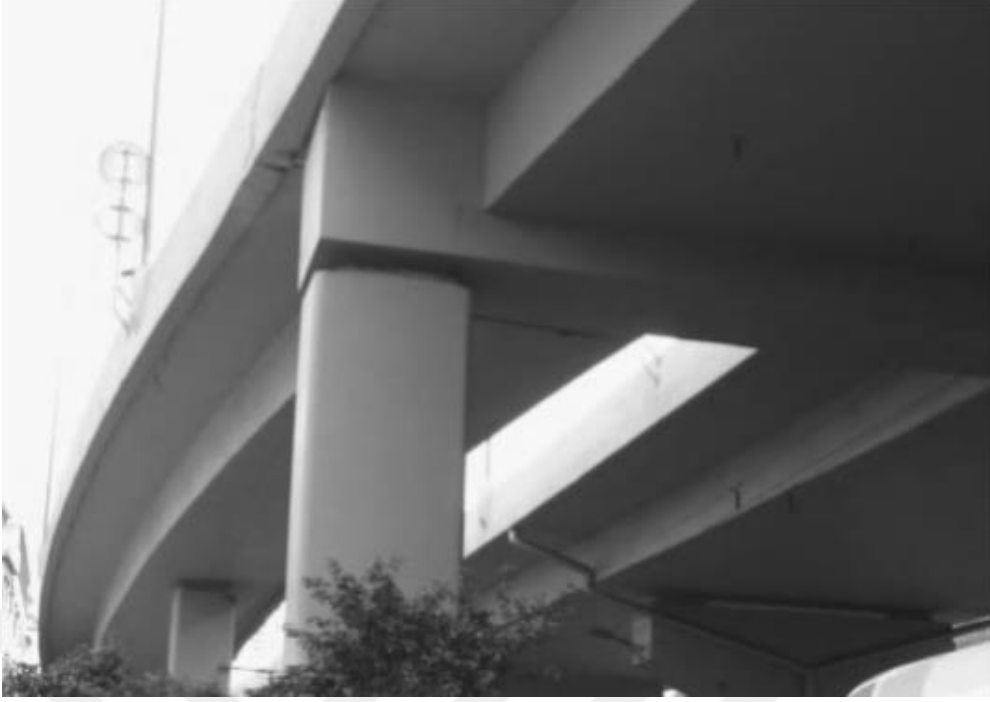
Şekil 2.7. Eğri eksenli beton kutu kirişli köprü (Fu, 2013)
