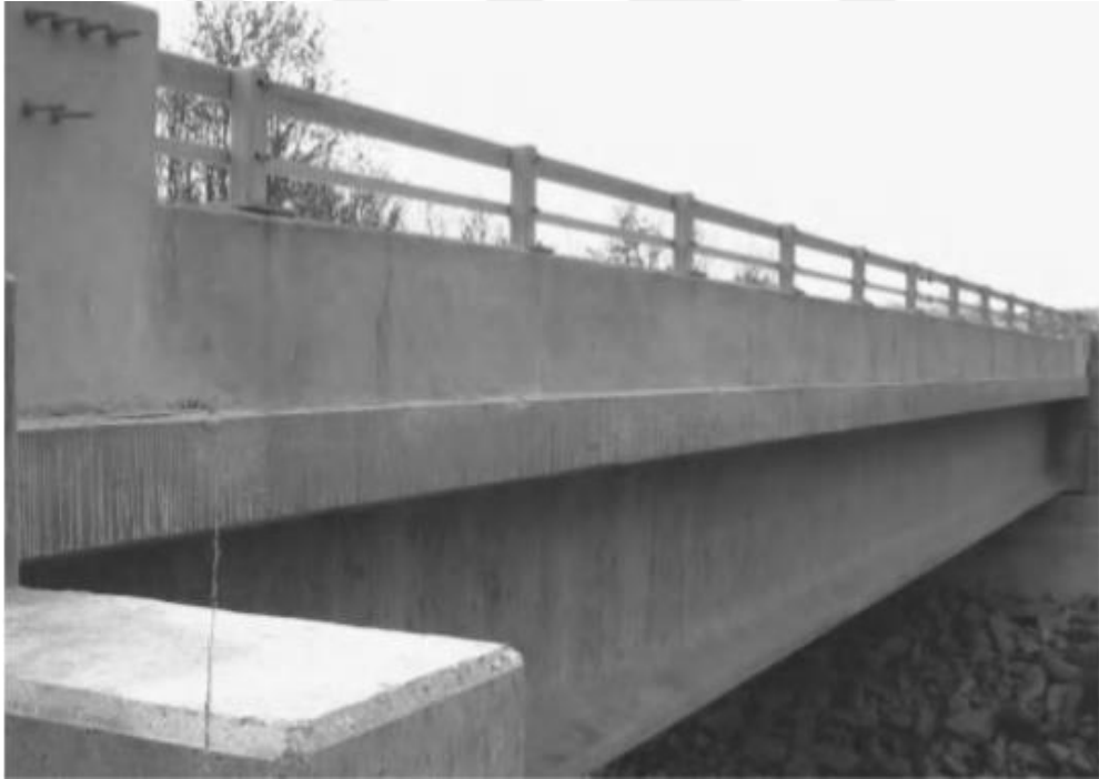
Şekil 2.8. Tek açıklıklı öngerilmeli betonarme I-kirişli köprü (Fu, 2013)
