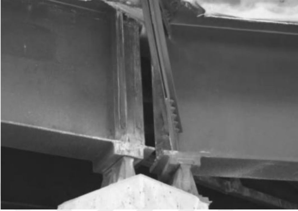
Şekil 2.5. Bir iskeleyi paylaşan iki basit çelik kiriş (Fu, 2013)
