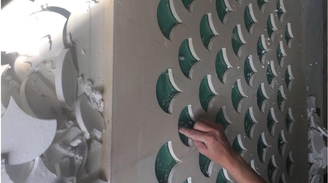
Resim-60: Kuruyan alçı içerisinde straforların çıkarılması
