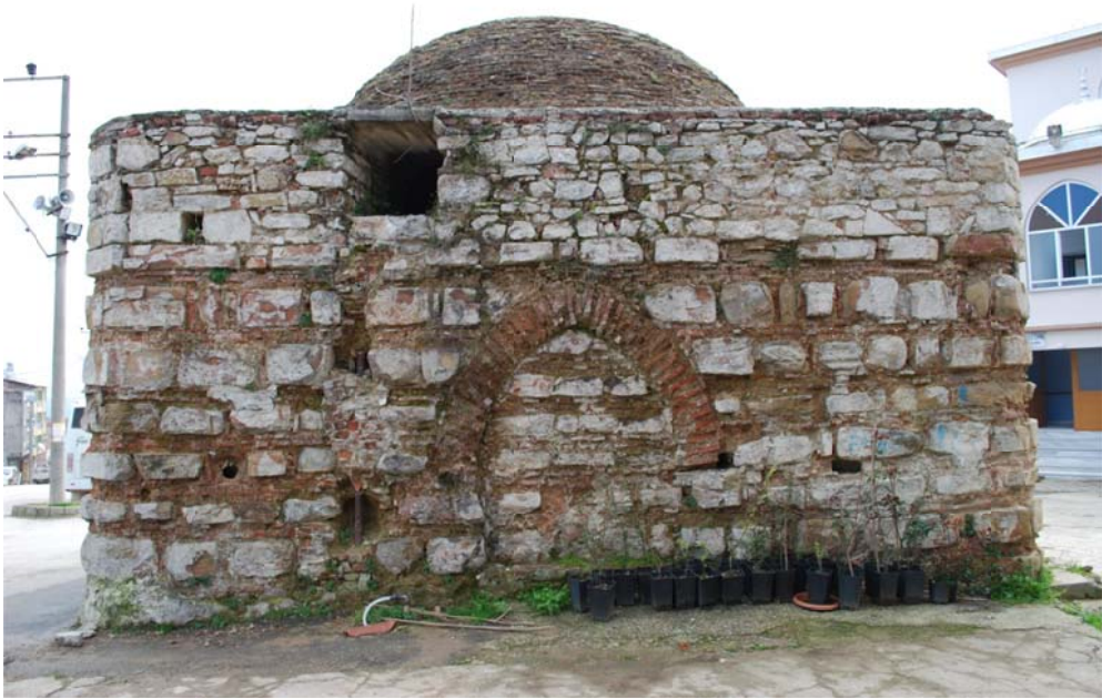
Fotoğraf 5. Doğu cephesi
