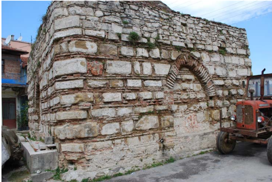
Fotoğraf 7. Kuzeybatı cephesi
