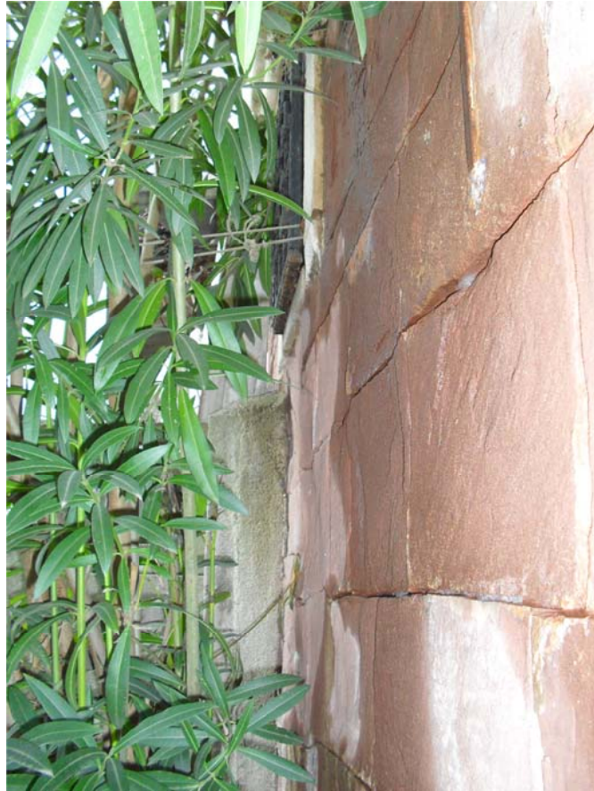
Fotoğraf 11. Batı cephesindeki hazne penceresi
