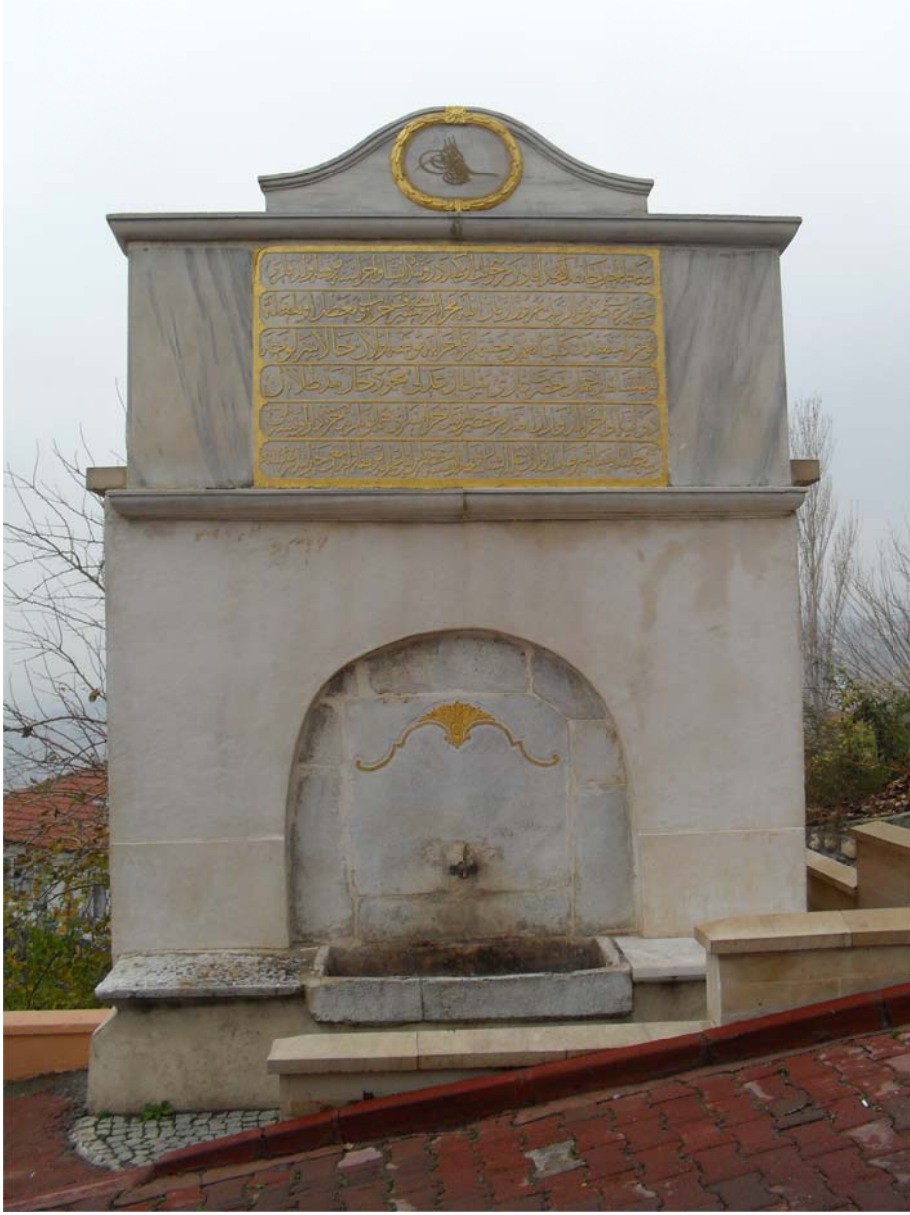
Fotoğraf 18. Doğu cephesi
