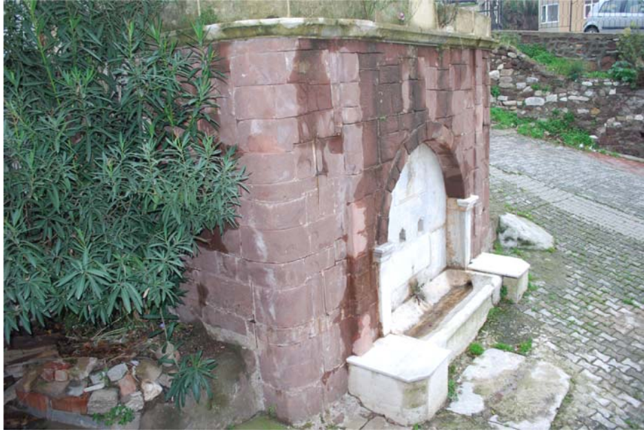
Fotoğraf 10. Güneybatı cephesinden görünüş
