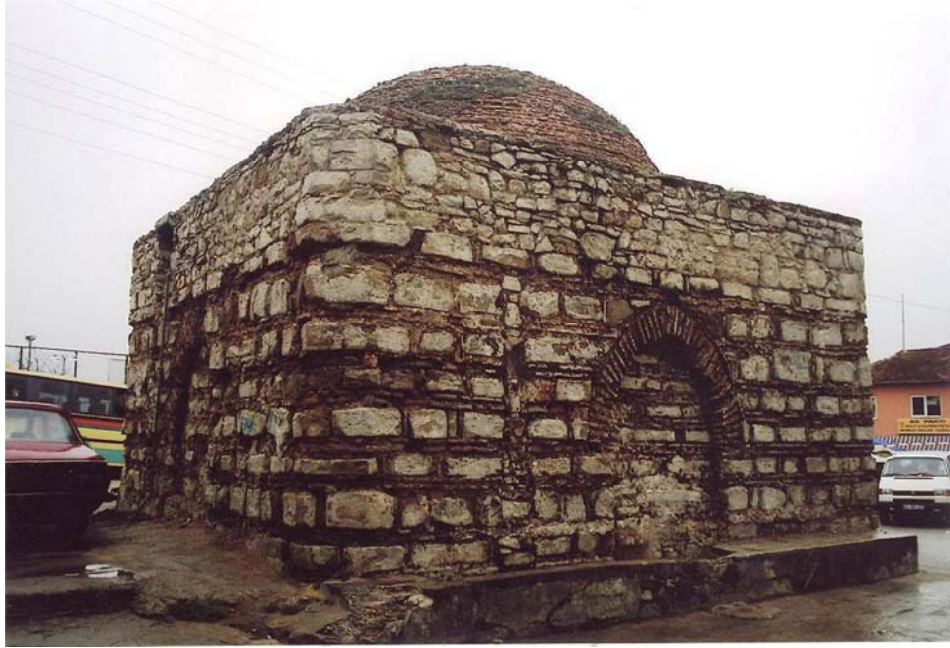
Fotoğraf 6. Kuzeydoğu cephesi
