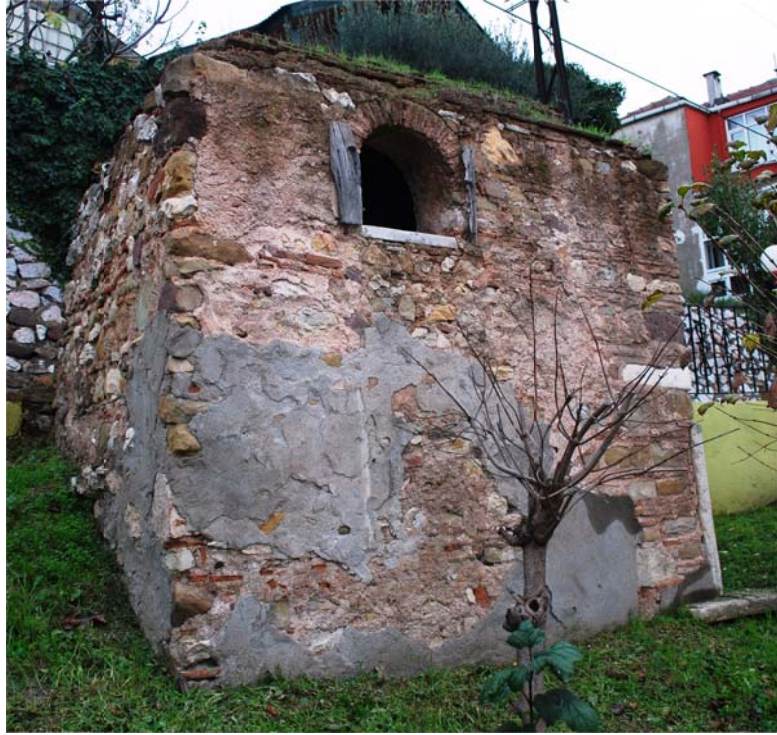
Fotoğraf 32. Doğu cephesi
