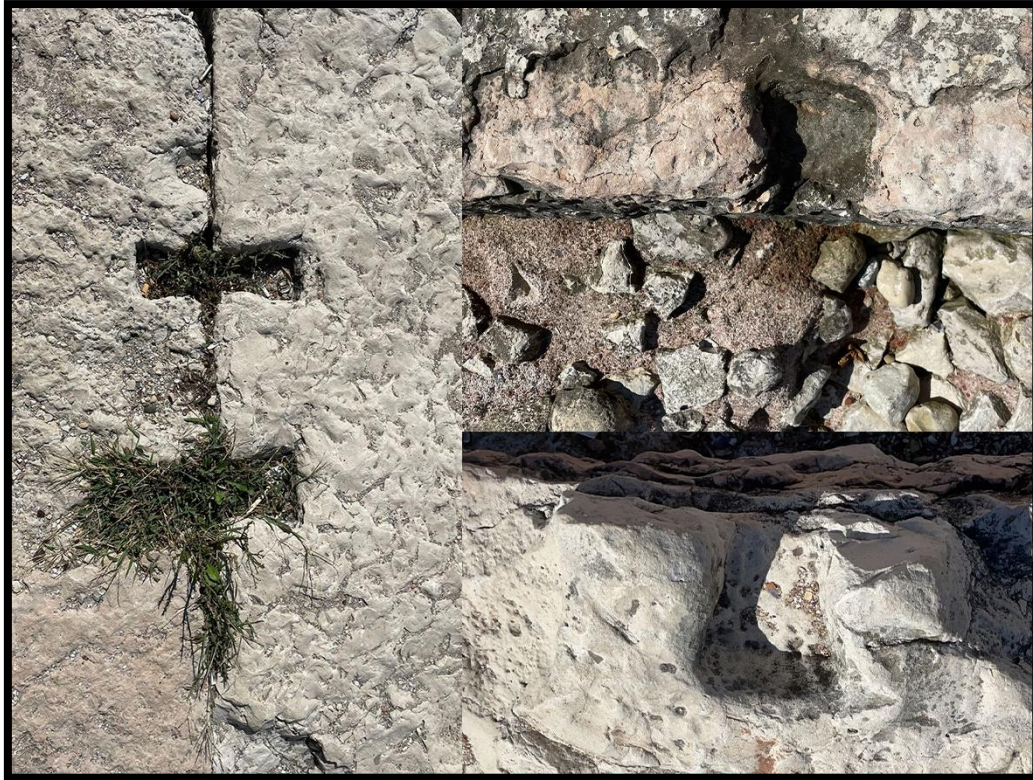
Resim 51: Antik Kerpe Limanı mendireğinde bulunan kenet yuvaları
