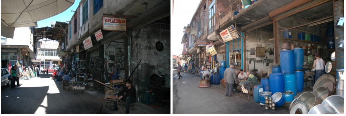
Şekil 4.20: Malatya Bakırcılar Çarşısı Restorasyon müdahalesi öncesi (URL 21).
