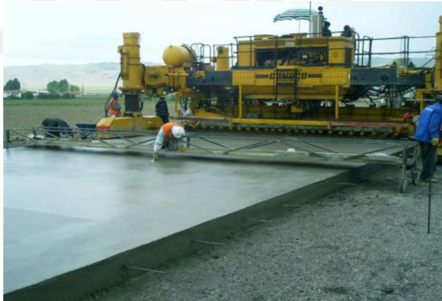
Şekil 1. Afyon-Emirdağ beton yol görüntüsü (URL-3).
