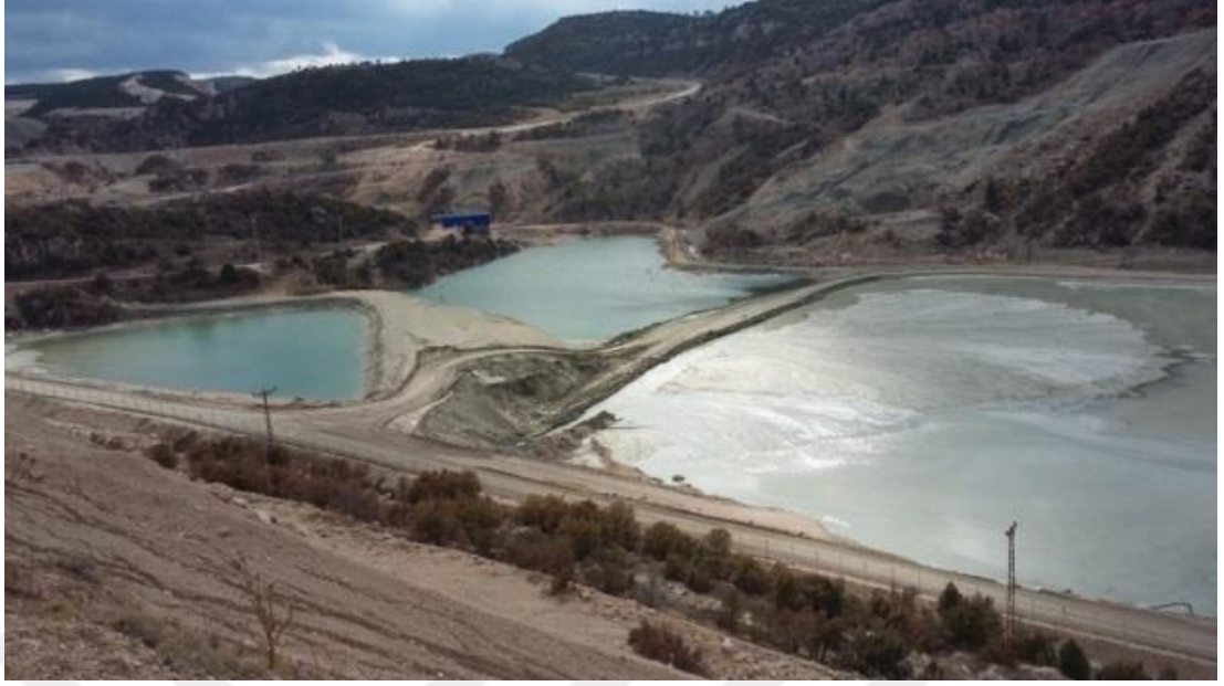
Şekil 4.1 Emet Bor Tesisinde bulunan KA atık barajı (Kişisel arşiv, 2017)
