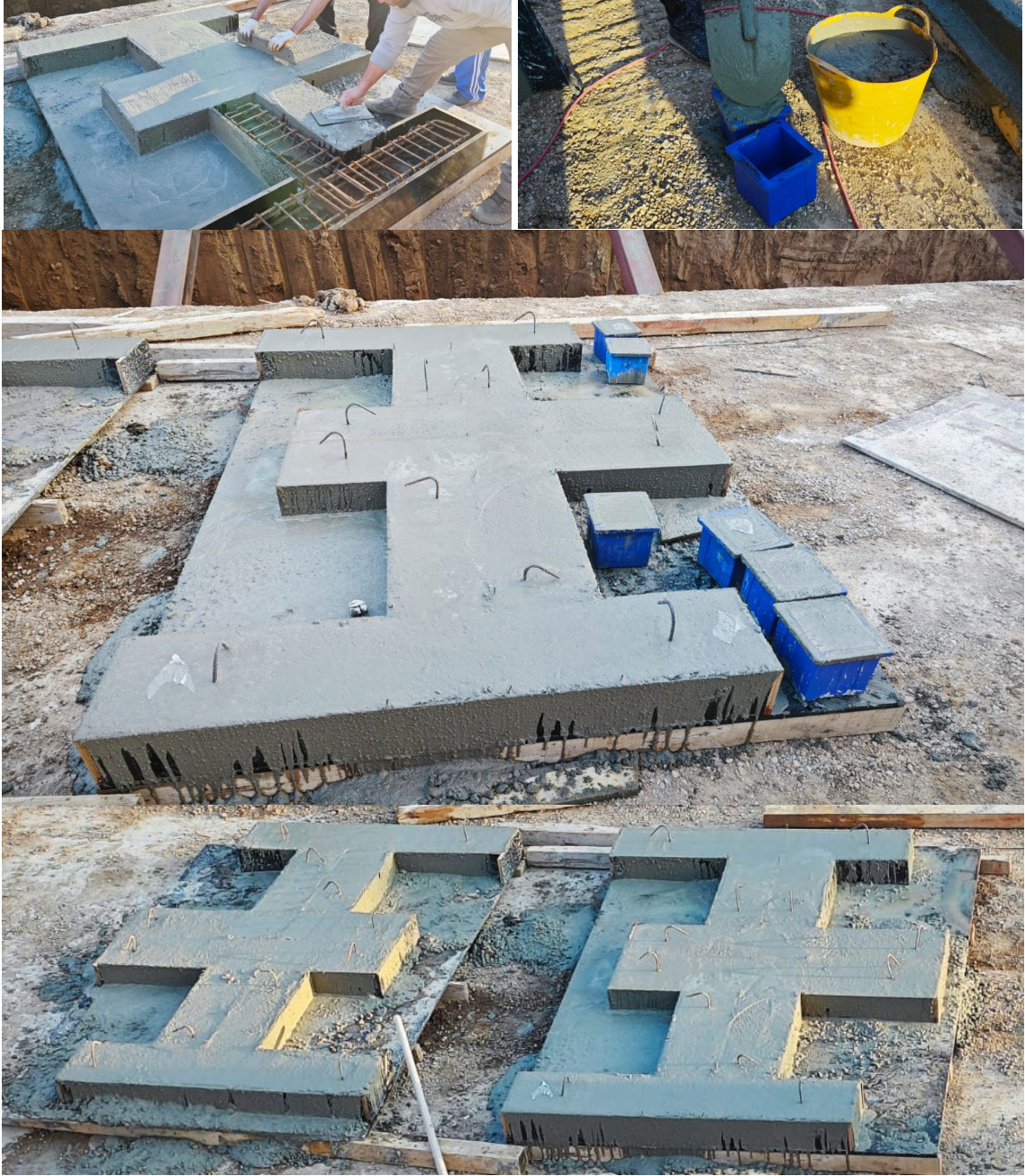
Şekil 3.13. Betonlama ve numune alma işlemlerine ait görseller.
