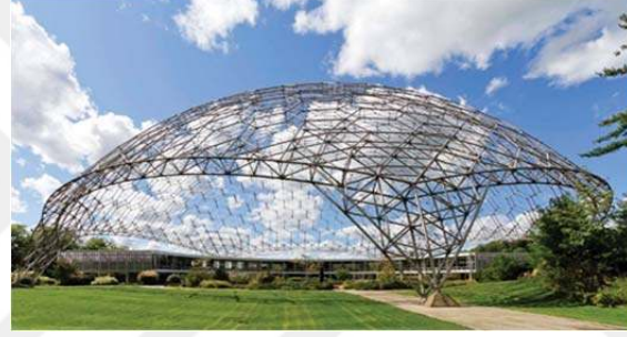
b) ASM Uluslararası Merkez Binası, Buckminster Fuller, 1959, Ohio/ ABD, Kubbesel kafes sistem örneği (Url 4.50) Şekil 4.22. Kafes sistem strüktür örnekleri
