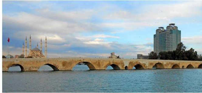
Şekil 4.2. Yapı olarak strüktür örneği, Taşköprü, Adana (Url 4.2)
