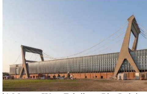
b) Mantua Kâğıt Fabrikası, Pier Luigi Nervi, 1961, Mantua/ İtalya, Tek kablolu sistem örneği (Url 4.52)
