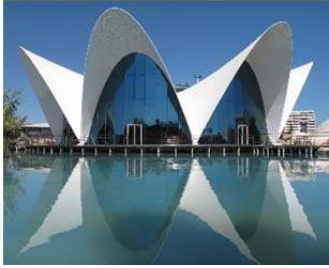
c) Los Manantiales Restoranı, Felix Candela, 1958, Meksika- Kabuk strüktür örneği (Url 4.47)
