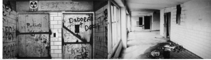
Şekil 5.26. Pruitt-Igoe, üzerinden, kullanıcılar tarafından benimsenmeyen tasarım anlayışının, vandalizme uğramasının örneklenmesi (Url 5.32)
