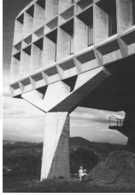
a) Yapıya ait kolon (Url 6.63)
