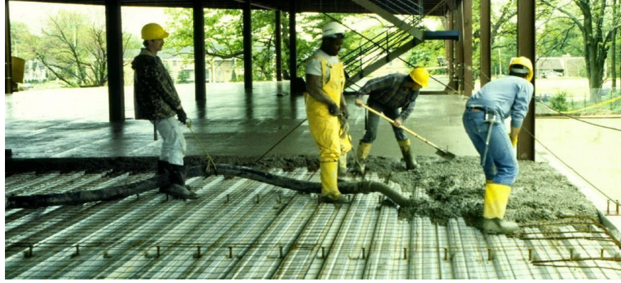
Şekil 3.2. Beton dökümü
