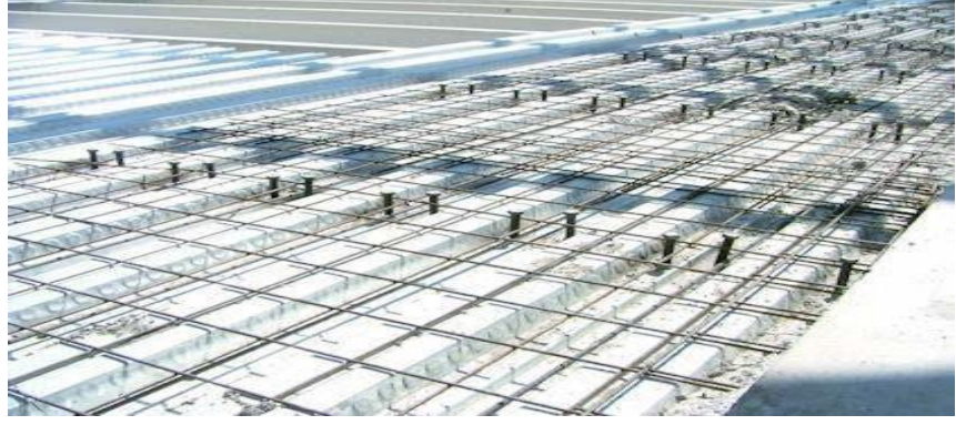
Şekil 3.8. Kayma Bağlantısı – Stud Çivisi
