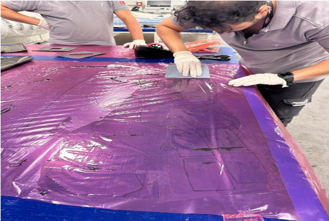
Grsel 3.20. Kompozit tamiri reine uygulaması
