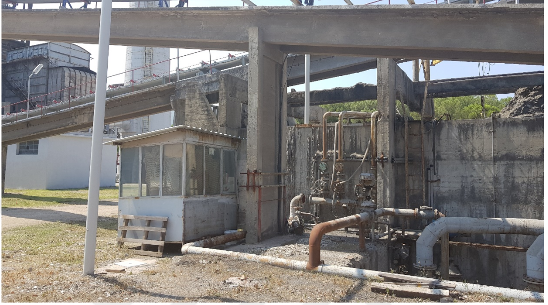
Şekil 5.3 Konveyör bandın altında konumlandırılmış basınçlı su sistemi (Kişisel arşiv, 2019)
