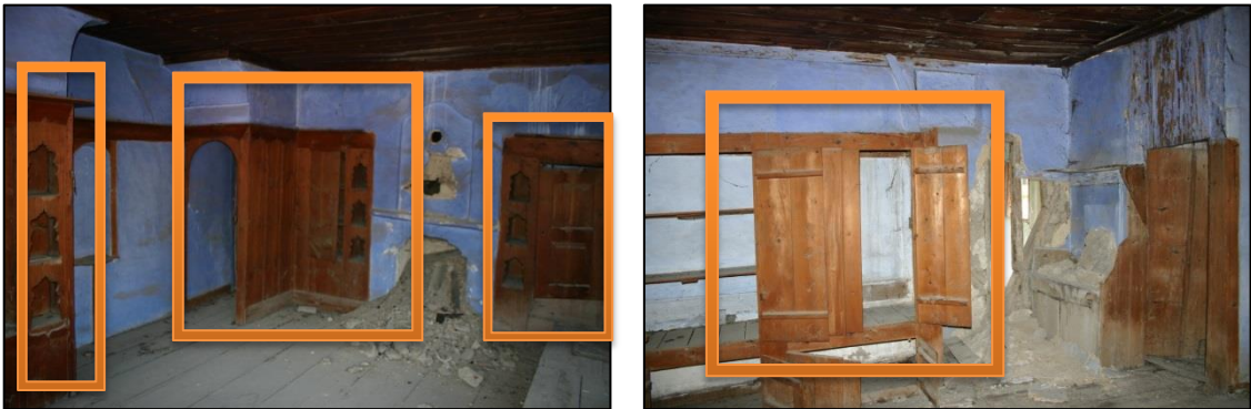
Şekil.107. Yapının Mevcut Halinden Alınıp Onarılarak Kullanılabilecek Elemanlar
