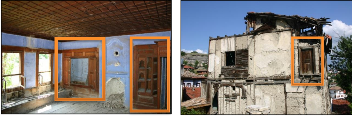
Şekil.108. Yapının Mevcut Halinden Alınıp Onarılarak Kullanılabilecek Elemanlar
