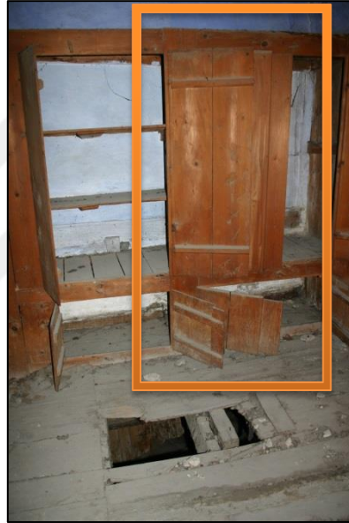
Şekil.109. Yapının Mevcut Halinden Alınıp Onarılarak Kullanılabilecek Elemanlar
