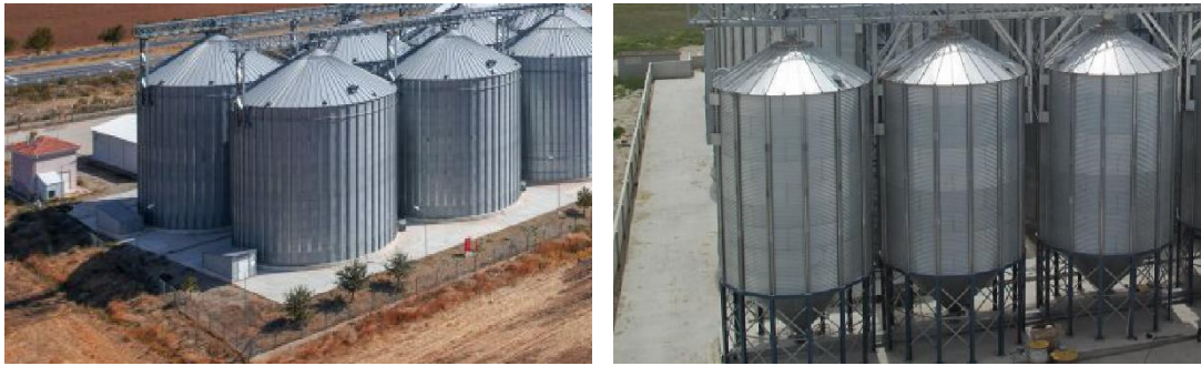
Şekil 1.3. (a) Düz tabanlı (URL-4) ve (b) konik tabanlı silo (URL-5).
