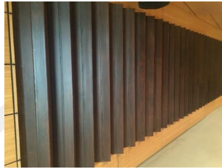
Şekil 15. Ahşap Yansıtıcı Duvar Panelleri
