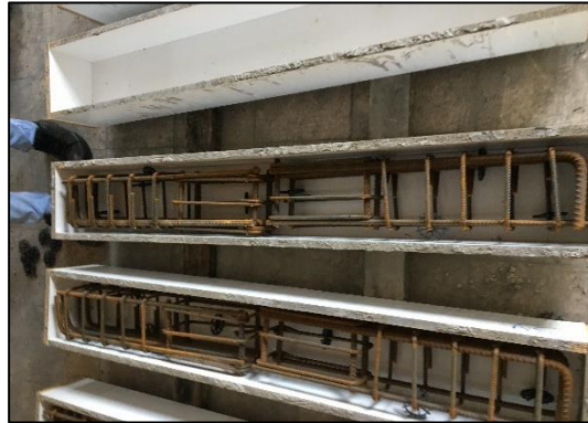
Şekil 4.17. Donatıların kalıplara yerleştirilmesi ve paspaylarının konulması
