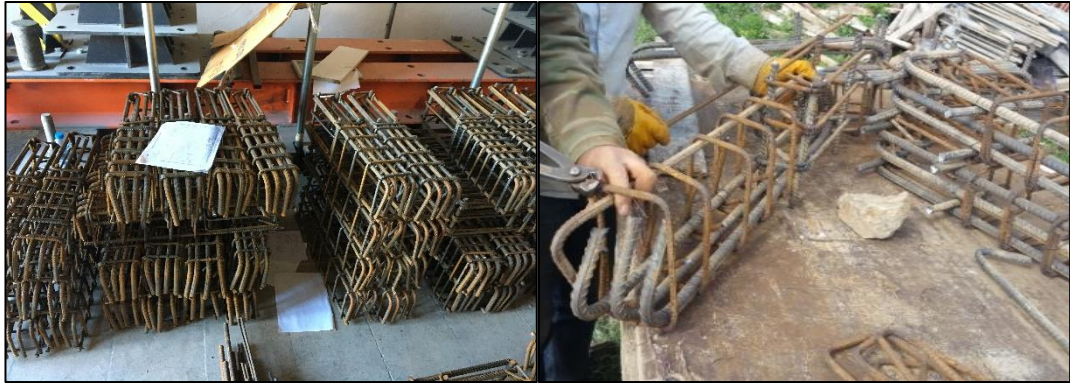
Şekil 4.8. Donatı imalatı
