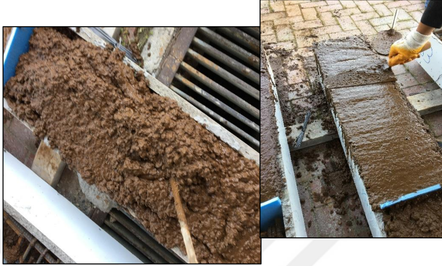
Şekil 4.18. Betonun kalıplara yerleştirilme işlemi
