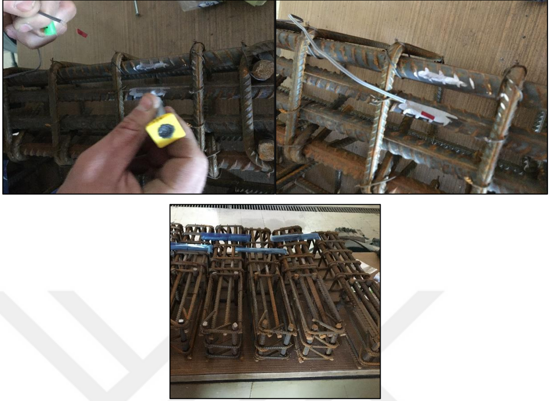
Şekil 4.13. Gerinim pullarının ilgili donatılara yapıştırılması
