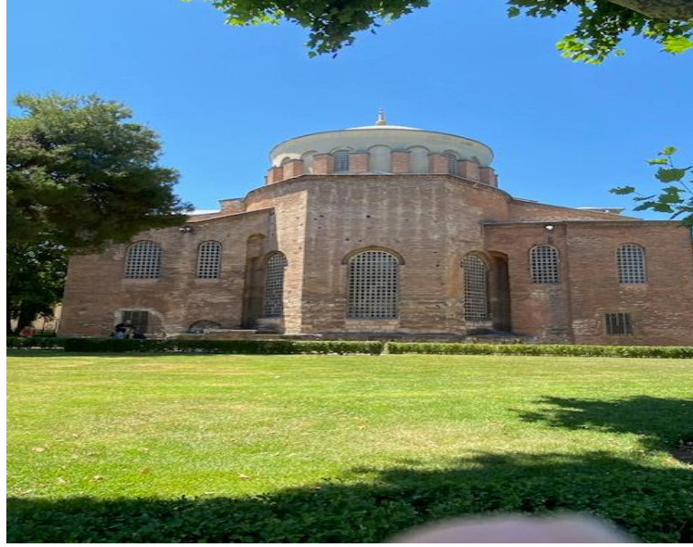
Fotoğraf 1: Aya İrini Kilisesi, dıştan görünüm. 279
