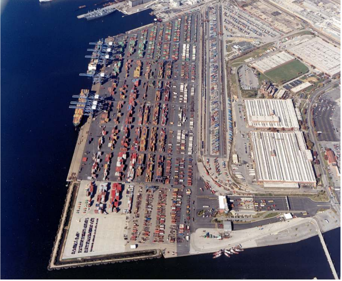
Şekil 4.11 Seagirt Marine Terminali'nde açık depo alanı
