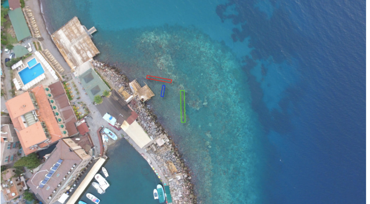
Fig. 31. Mendireğin 2. fazına ait duvar kalıntıları
