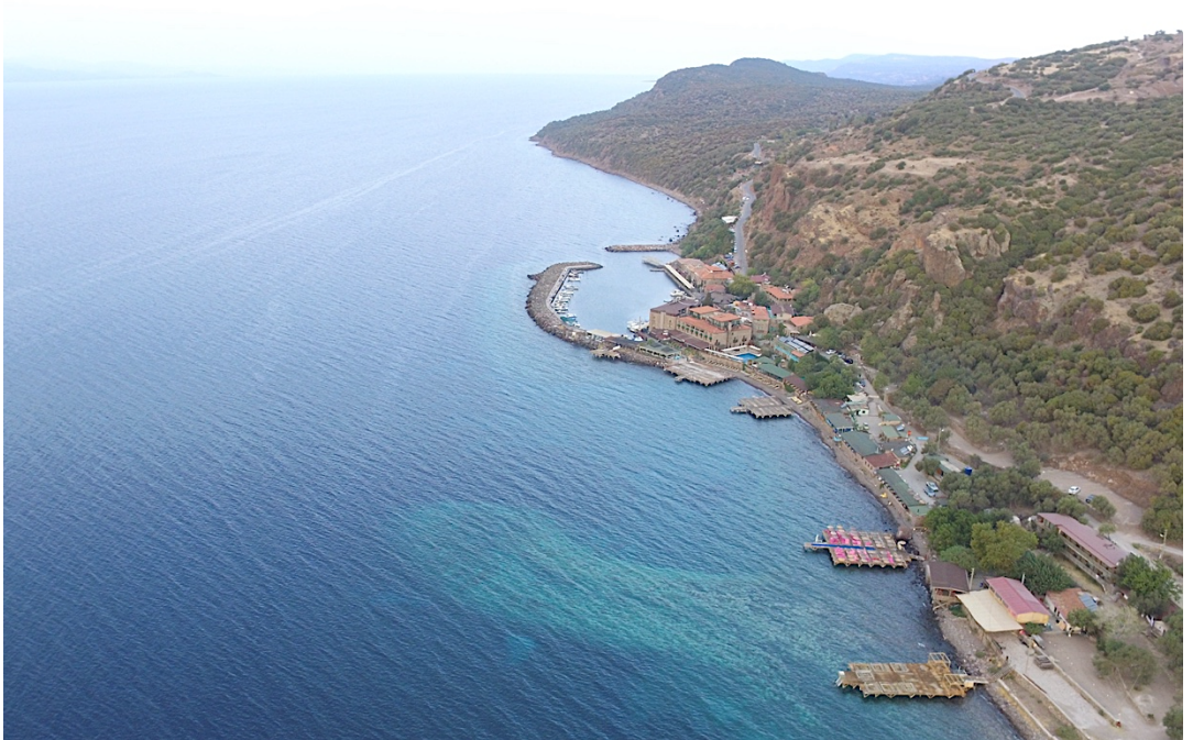
Fig. 29. Assos Limanı mendirek yapılarına ait hava fotoğrafı
