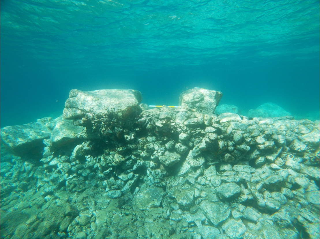
Fig. 36. Doğu'daki mendireği oluşturan blokların altındaki moloz dolgu
