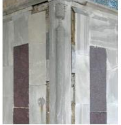
Taşın Kaplama Malzemesi Olarak Kullanımı (Topkapı Sarayı - Bağdat Köşkü)
