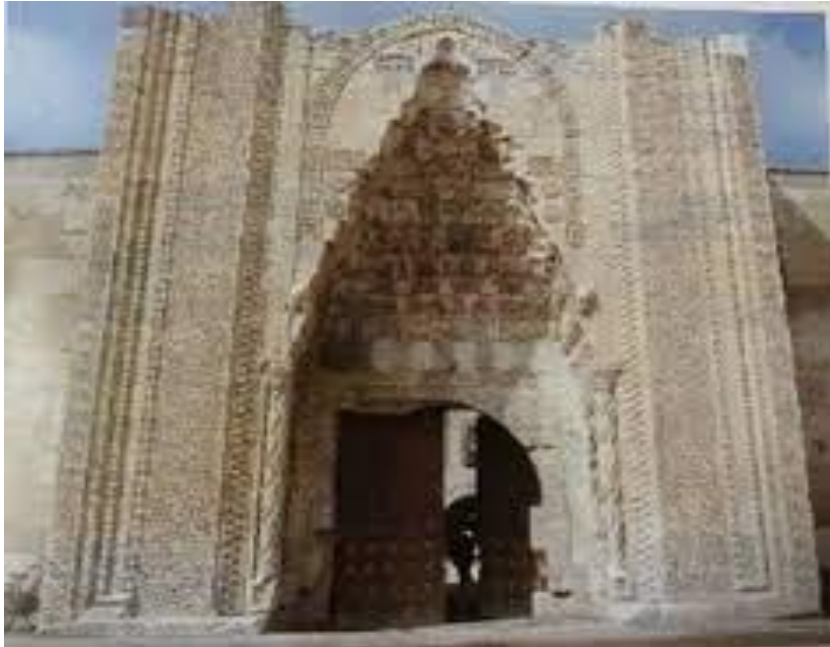
Şekil 2. 2: Yapı malzemesi olarak taşın kullanımı.
