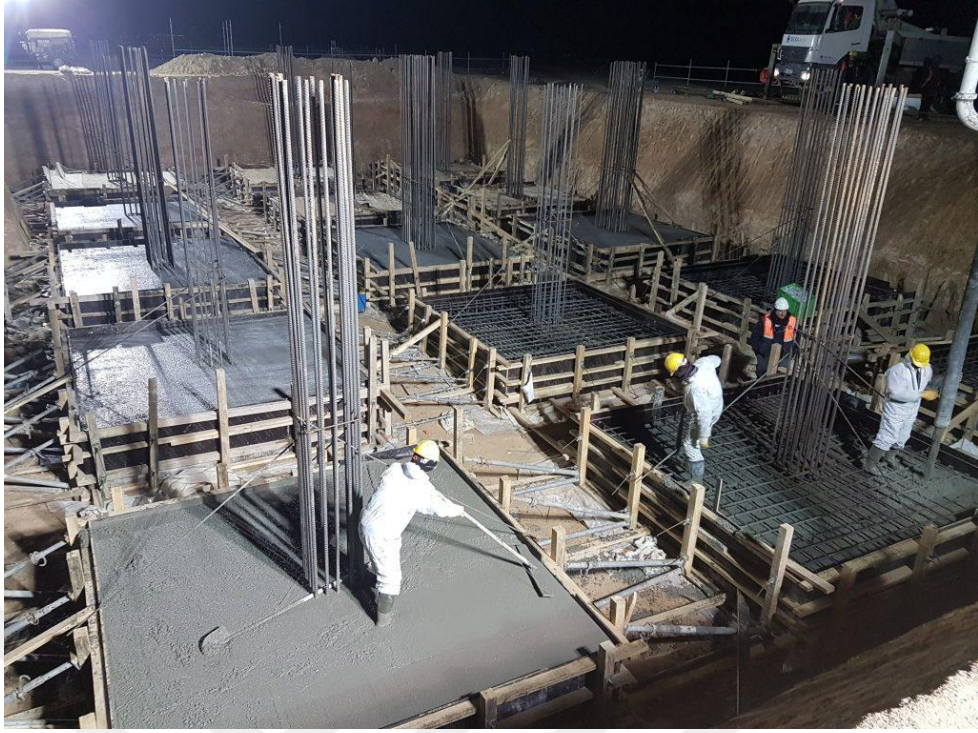
Şekil 5. 5: Beton ile çalışmalarda uygun kişisel koruyucu donanım kullanımı.
