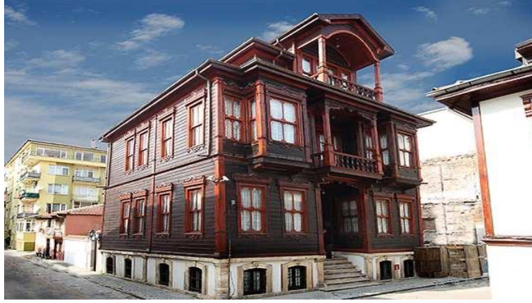
Şekil 2. 22: Ahşaptan yapılmış ev (Mihran Hanım Konağı).
