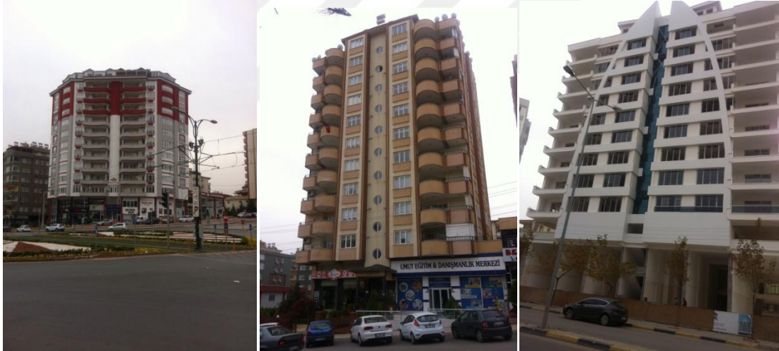
Şekil.4.11. Atatürk mahallesi Soydınç Plaza Görünüş
