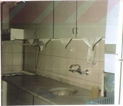
Şekil 6.19. O-1 nolu konutun suntalam mutfak dolapları
