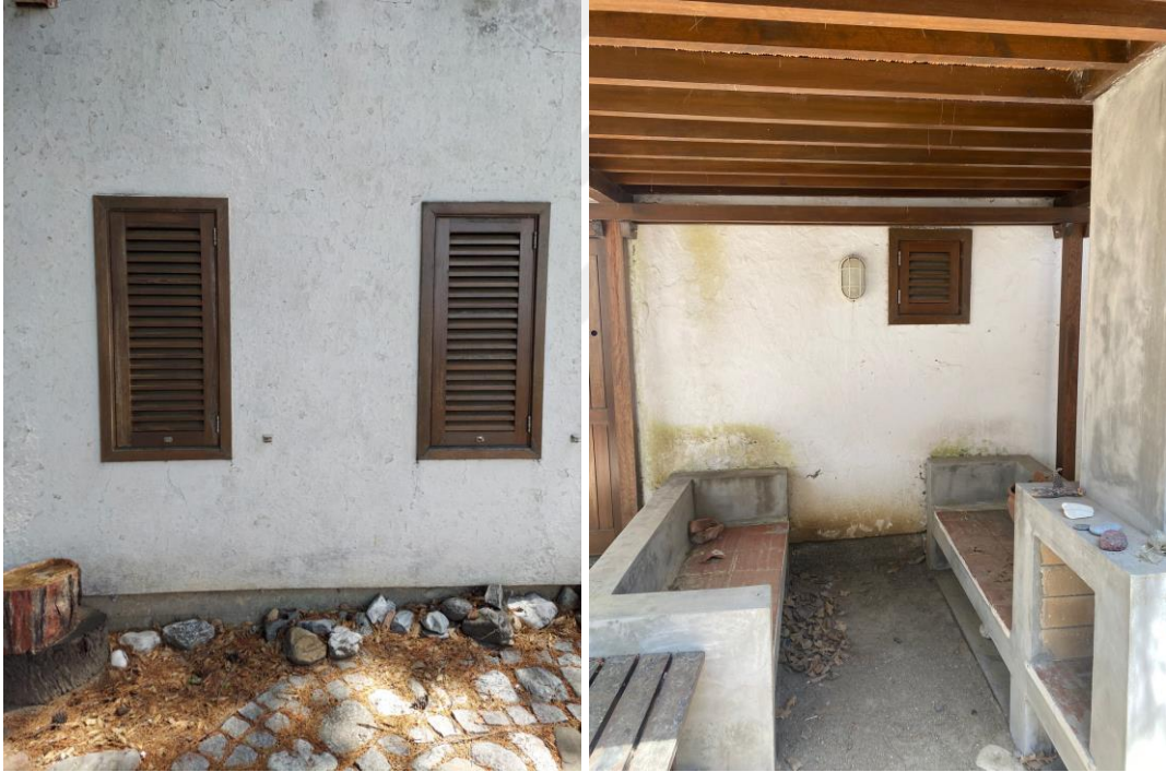
Resim 52. Güzin Gürel'in Kız Kardeşleri ve Ailesi İçin Olan Uyku Ünitesinin İklim Koşullarına Uygun Tasarlanan Küçük Camları ve Pergola İle Oluşturulan Gölge Alan
