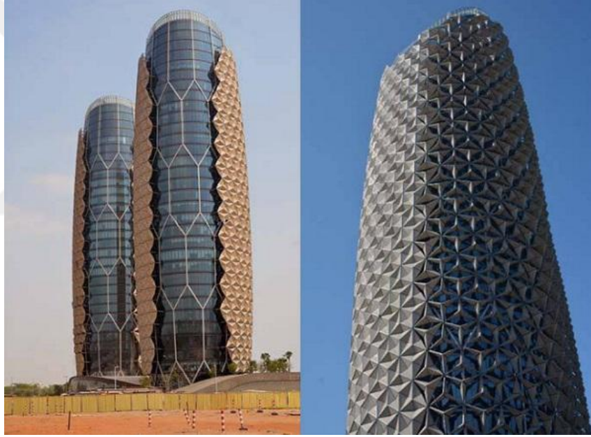
Resim 8. Güneşin Döngüsüne Bağlı Çalışıp Mevsimsel ve Gün İçinde Oluşan Isı Değişimlerine Uyum Sağlayan Hareketli Cephe Sistemine Sahip Al Bahar Kuleleri
