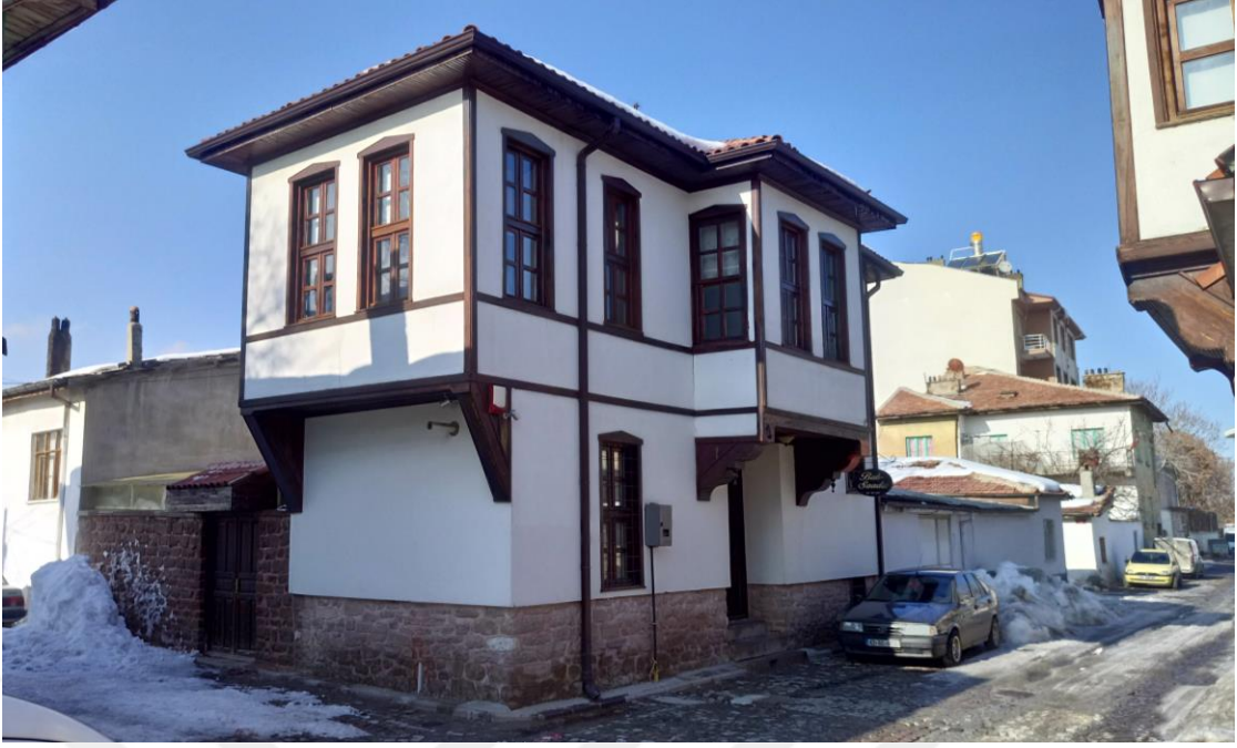
Şekil 2.10. Geleneksel Konya Subasman Seviyesine Kadar Taş Malzeme Kullanımı (Ada: 5204, Parsel: 16)
