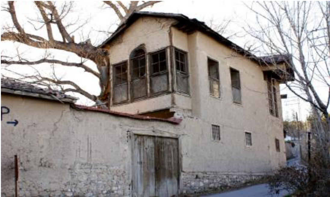
Şekil 2.7. Geleneksel Konya Evi Yapı Malzemelerinin Kullanımı (Ada: 647, Parsel: 36)
