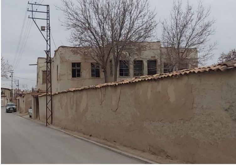
Şekil 4.1. Nakipoğlu Evi (Ada: 20355, Parsel:14)
