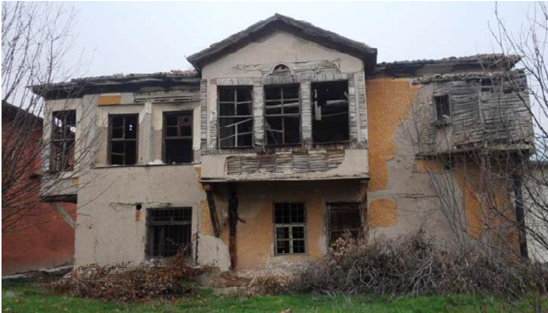
Şekil 2.9. Geleneksel Konya Evi Ahşap Malzemenin Cephede Sıva Tutucu olarak Kullanımı (Ada: 37508, Parsel: 3)
