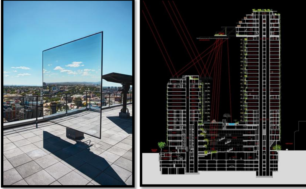
Şekil 2.14: One Central Park binasının çatısında kullanılmış heliostatlar [Url-10].
