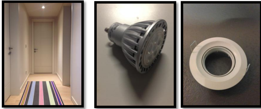
Şekil 6.15: Koridorda bulunan sıva altı led lamba ve aygıt görseli
