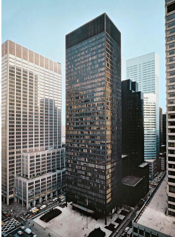
Şekil 2. 12 Seagram Binası cephe görünüşü, 1958, URL-11
