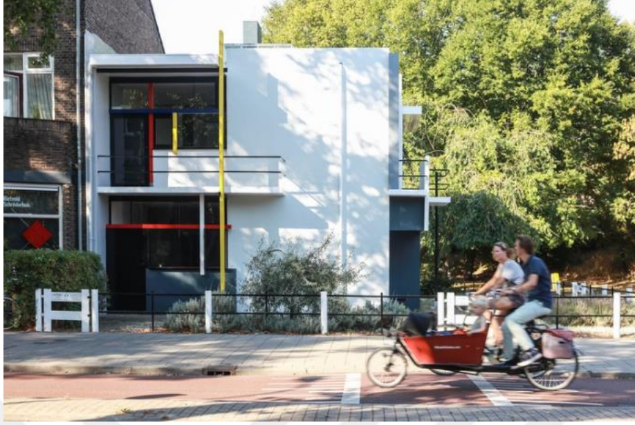
Şekil 2. 5 Schröder Evi cephe görünüşü, 1924, URL-4
