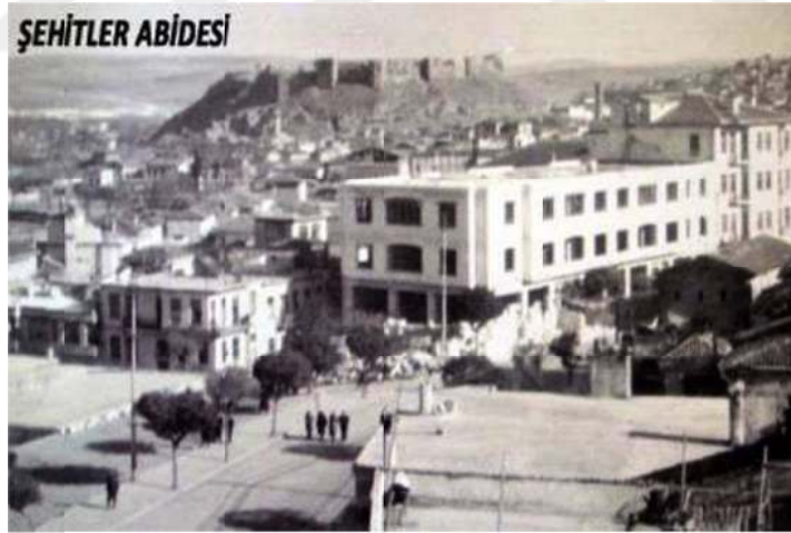
Şekil 4.1. Atatürk Bulvarı Üzerinde Yapılan İlk Apartman, Dr. Abdulkadir Göksel Apartmanı (Mihçioğlu, 2020)
