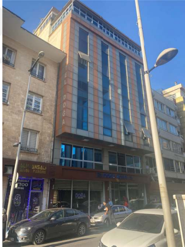
Şekil 4.15. Mahmut Ersoy Apartmanı yerine yapılan yapı, 2023
