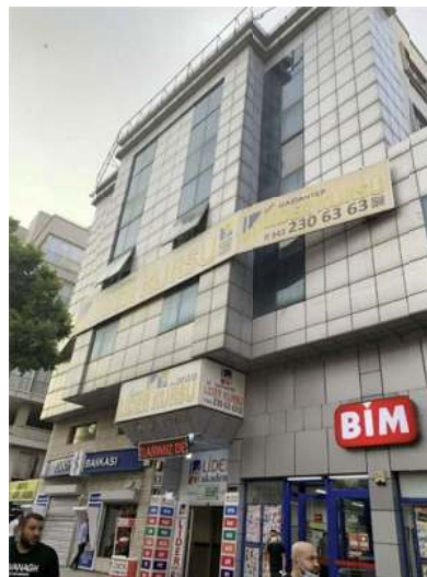
Şekil 4.18. Cemil Alevli Apartmanının Yerine Yapılan Yapı, 2023
