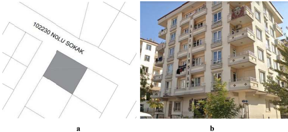
a b Şekil 5.10. Özçil Rezidans Konum ve Cephe Görseli, 2023
